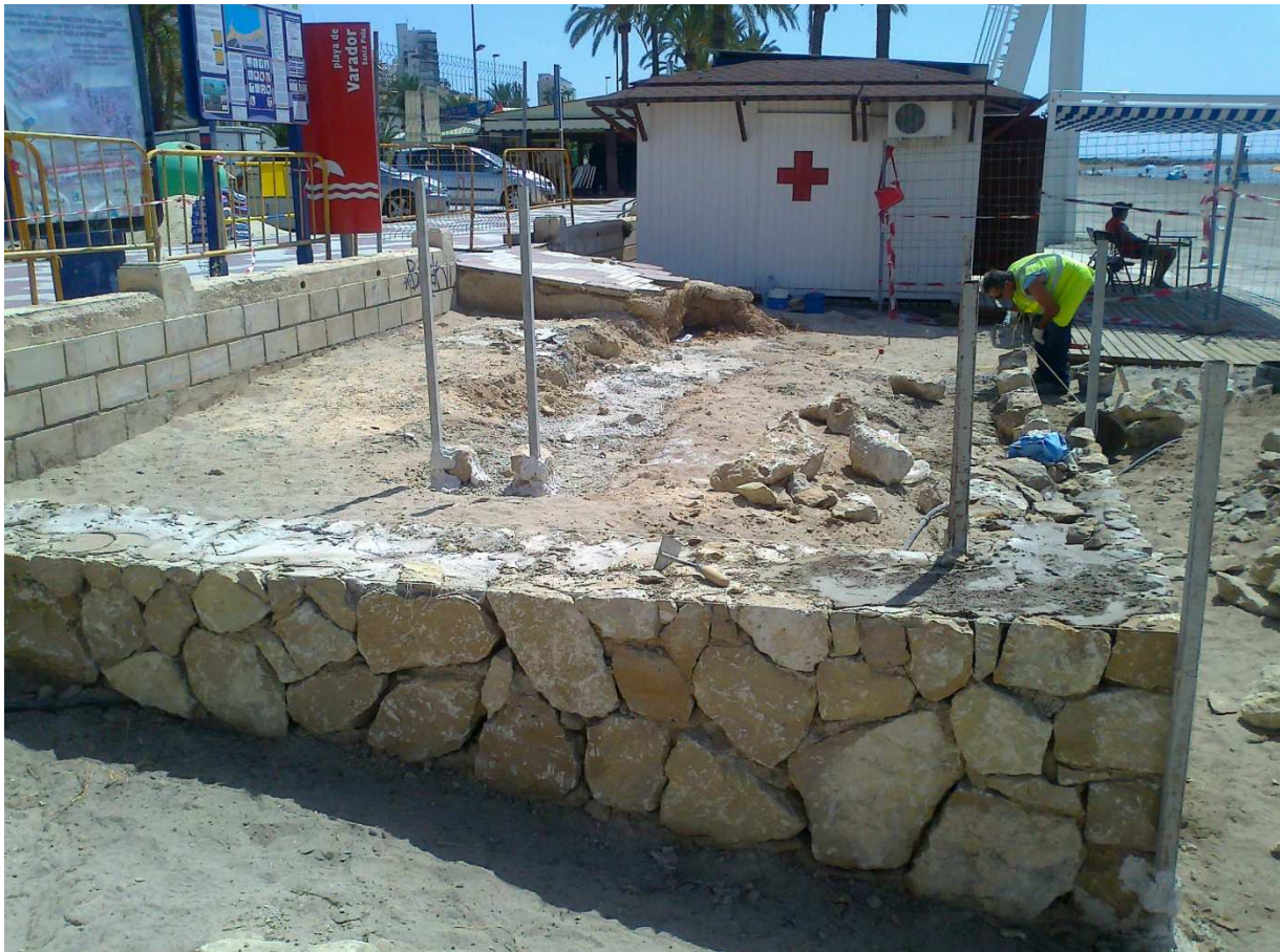
Fotos durante la obra:
