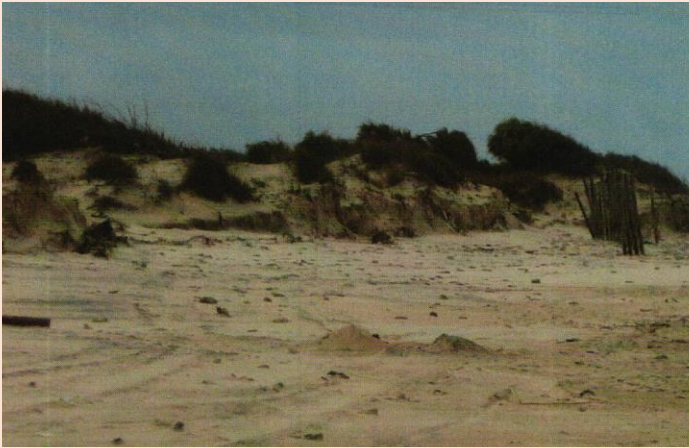
Ilustración 7: Perdida de arena en playa y afección al cordón dunar
