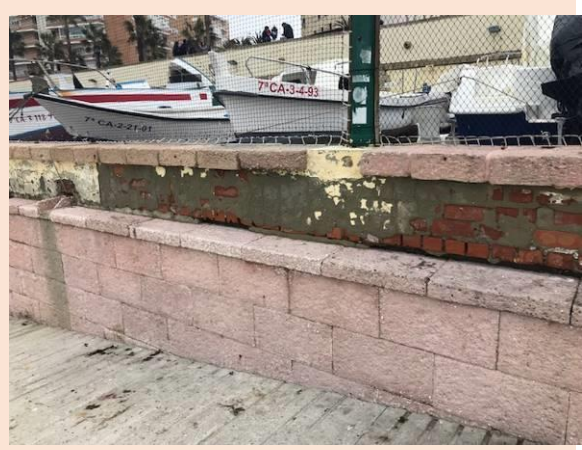
Ilustración 2: Detalle franja superior de muro
