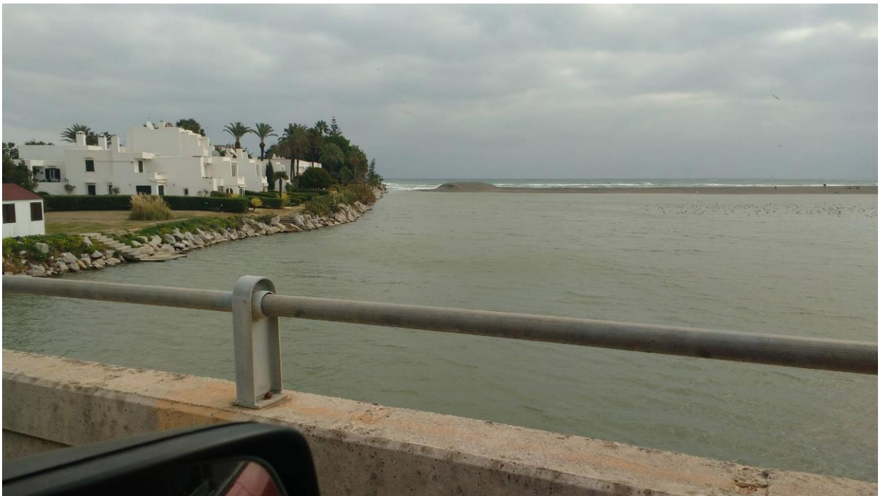
Zona extracción apertura río Guadiaro.
