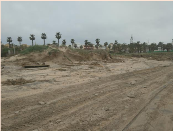
Ilustración 3: Daños en acceso, en el cordón dunar y pérdida de arenal
