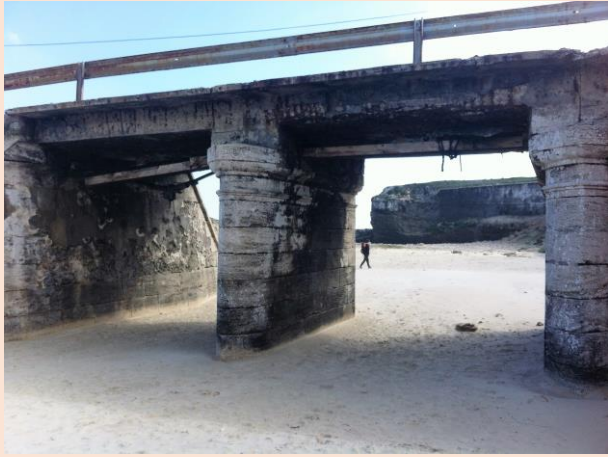
Ilustración 4 y 5 Paso inferior en playa Chica de la carretera de las Palomas dañado por el oleaje.
