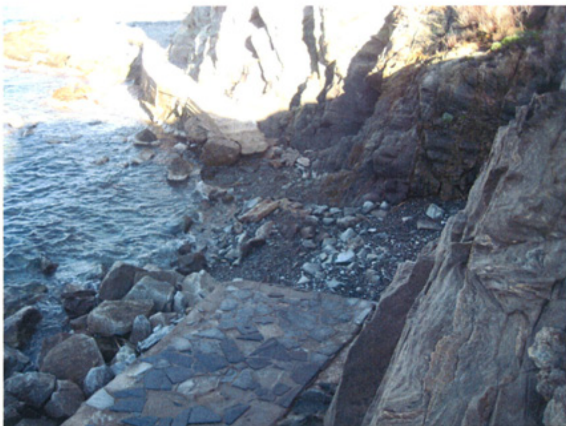
F2 – VISTA GENERAL DE LA ZONA A CONECTAR CALA CLISQUES Y VIOLETES.
