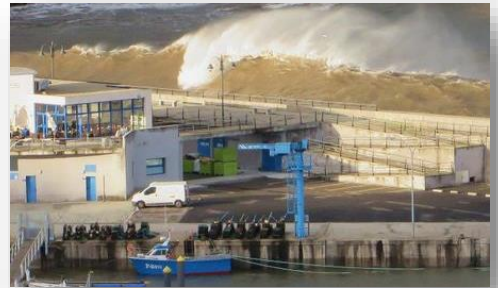
Figura 6. Las olas rebasan el dique exterior del Puerto de Candás
