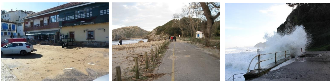
Figura 91. Daños sobre infraestructuras ocasionados por los temporales de 2014 en Tazones, Cuervas de Mar y Aguilar
