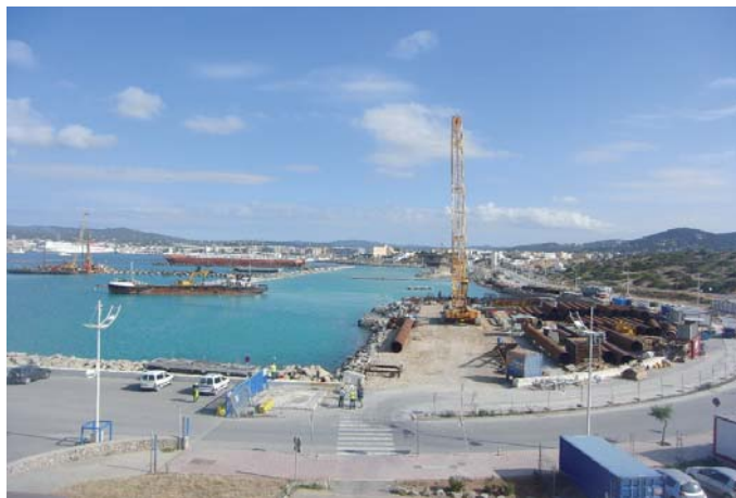
Figura 49. Explanada y muelles comerciales al abrigo del dique de Botafoc en Ibiza (Fuente: Anuario Estadístico de Puertos del Estado 2009)
