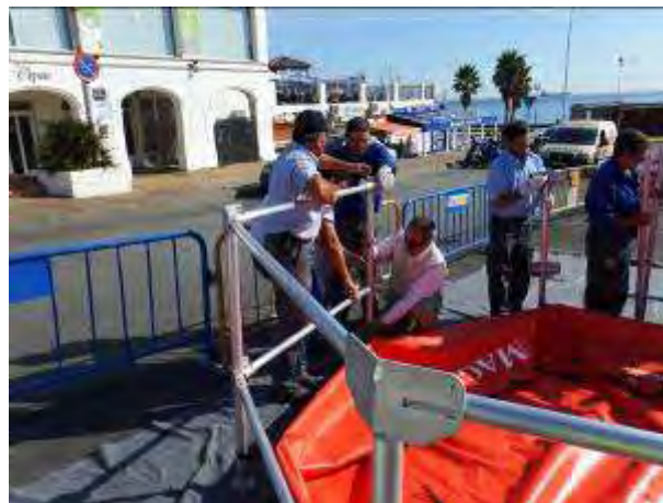
Figura 4: Depósito 10.000 L con estructura metálica.
