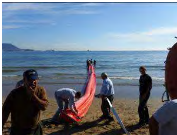
Figura 7: Tendido de barrera cilíndrica
