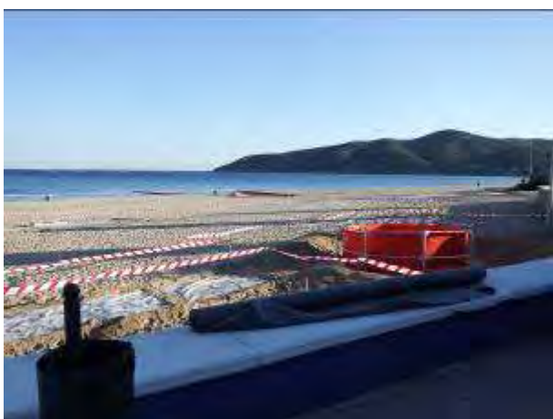
Figura 5: Instalación de pasillos en la playa
