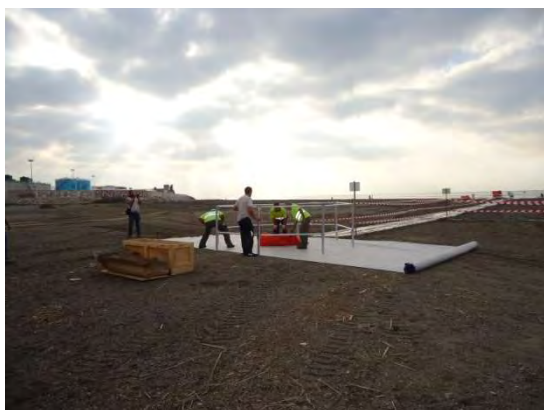
Figura 8: Instalación de pasillos en la playa
