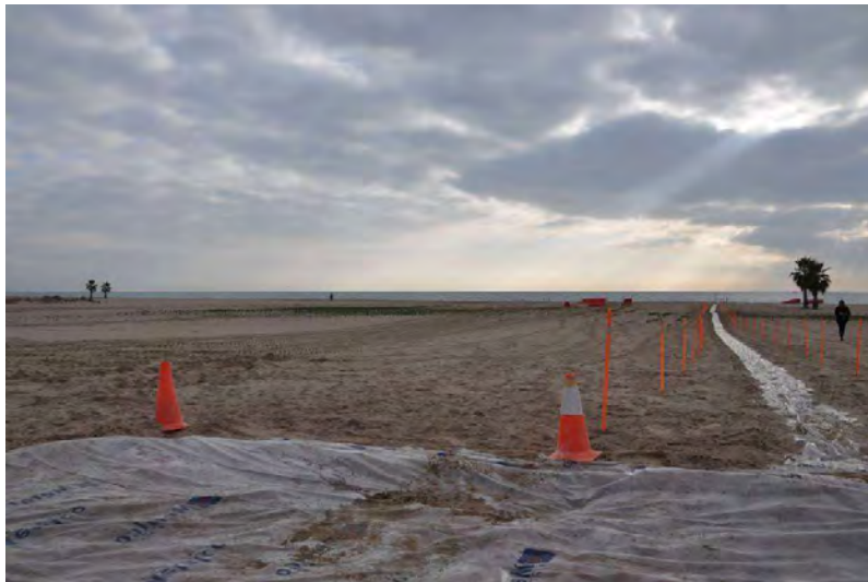
Figura 6: Instalación de pasillos en la playa
