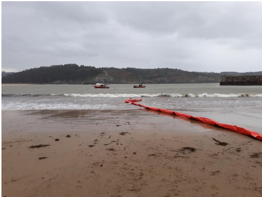
Ilustración 18. Maniobras de largado de las barreras.
