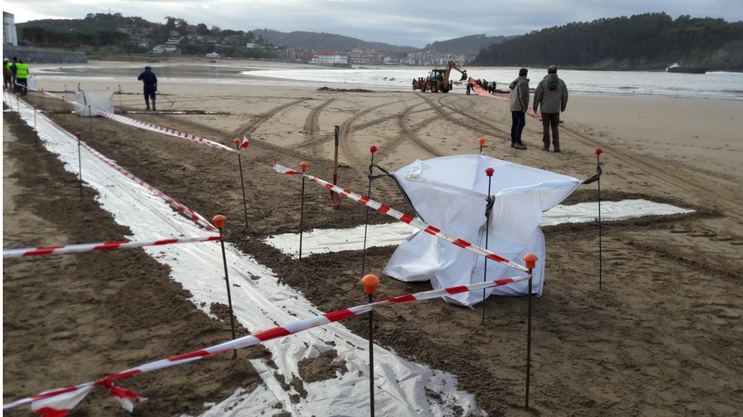
Ilustración 24. Pasillos de descontaminación y sacas big-bags en la zona de actuación.
