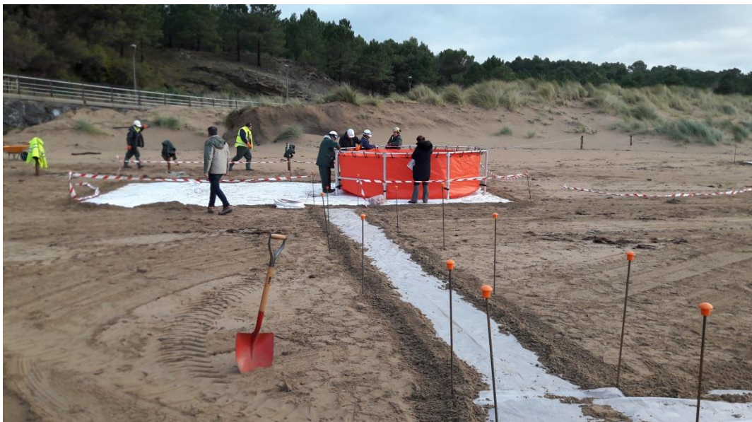
Ilustración 23. Montaje del Fast tank en la zona de almacenamiento temporal de residuos.
