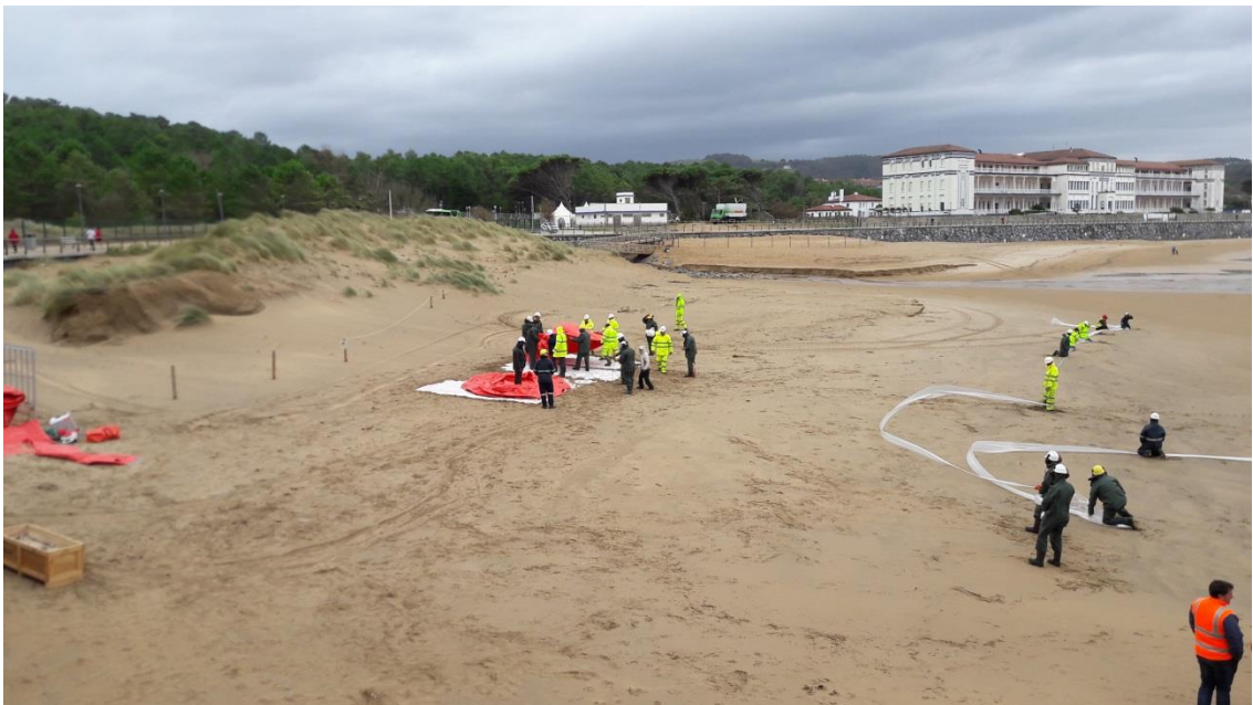
Ilustración 21. Personal interviniente realizando el montaje de los tanques de almacenamiento.
