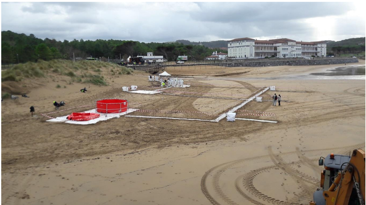
Ilustración 26. Fotografía general del área de intervención en costa.
