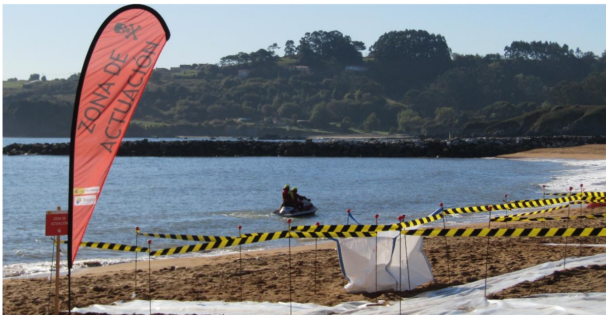
Ilustración 33. Personal interviniente creando los pasillos con lámina de polietileno y estabilizándolos con arena.
