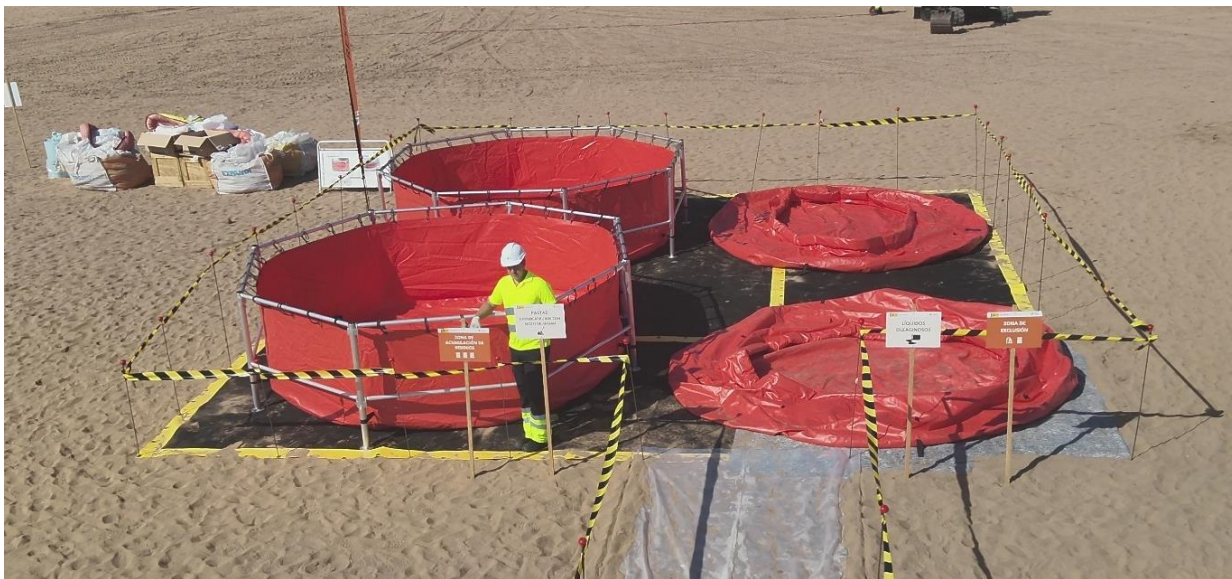
Ilustración 35. Zona de almacenamiento temporal de residuos (Tanques Autoportantes y tipo “Fast Tank”®).
