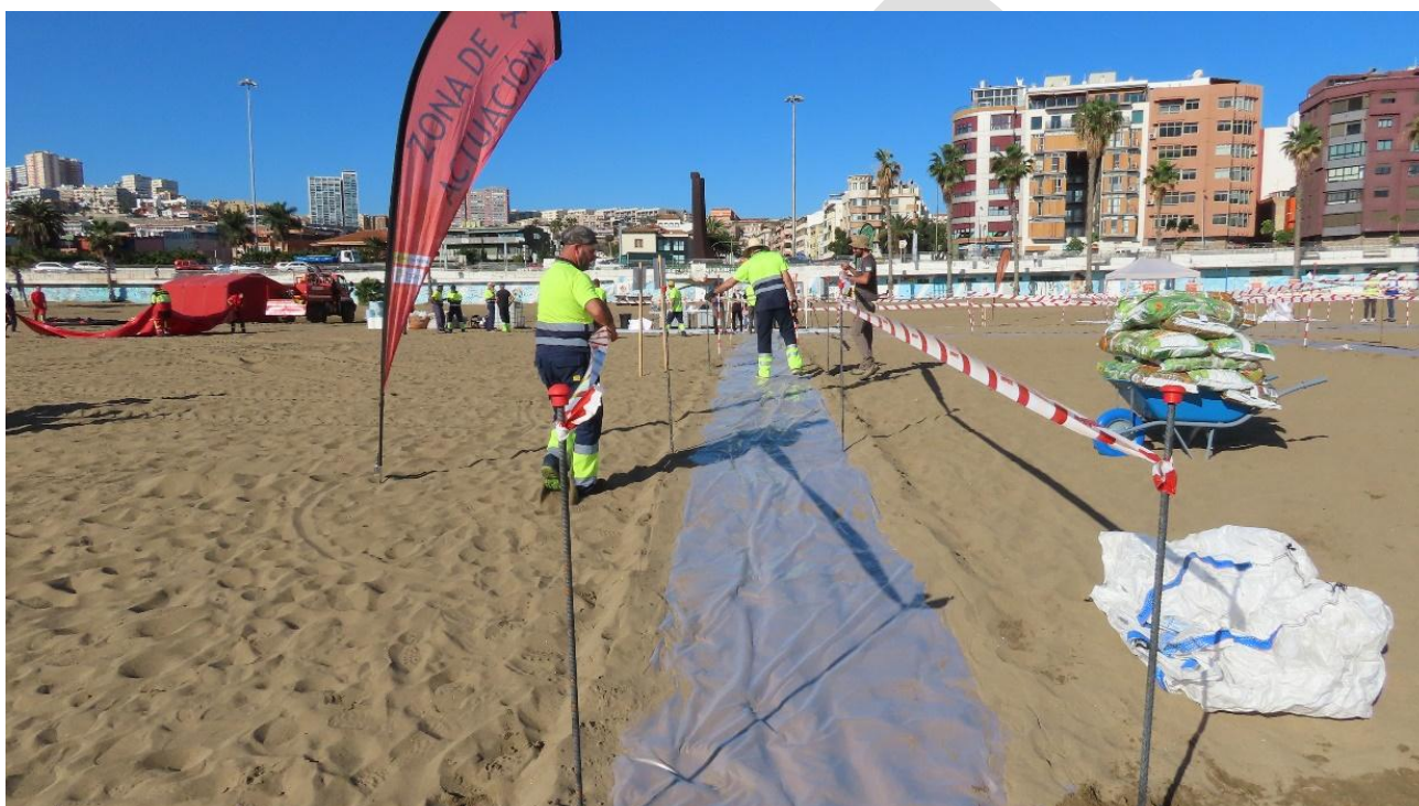
Ilustración 28. Personal interviniente balizando los pasillos de lámina de polietileno.
