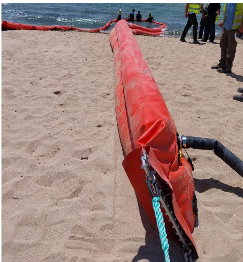
Ilustración 36. Llenado de las cámaras de agua de la barrera selladora.
