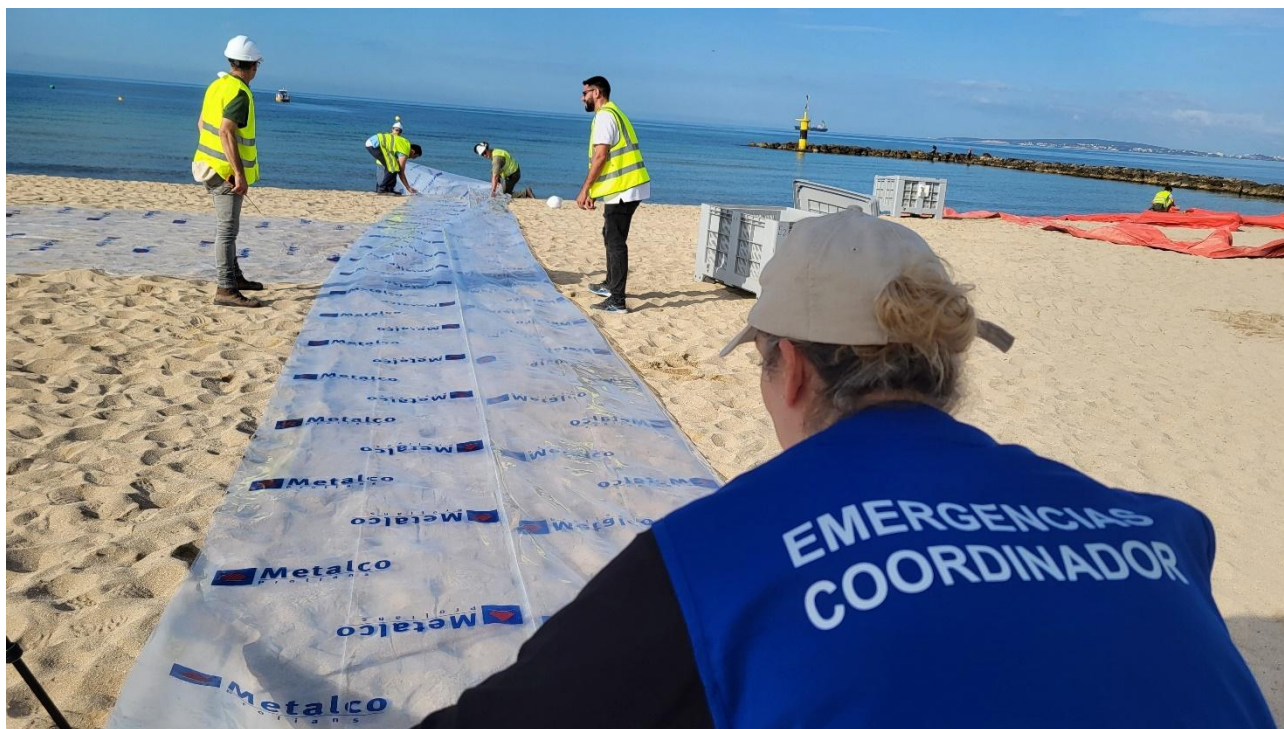
Ilustración 39. Personal interviniente creando los pasillos con lámina de polietileno.
