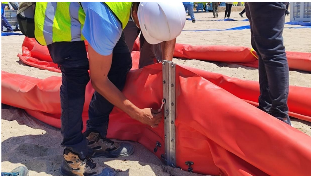
Ilustración 35. Empatado de 2 tramos de barreras cilíndricas y ajuste de pasadores.
