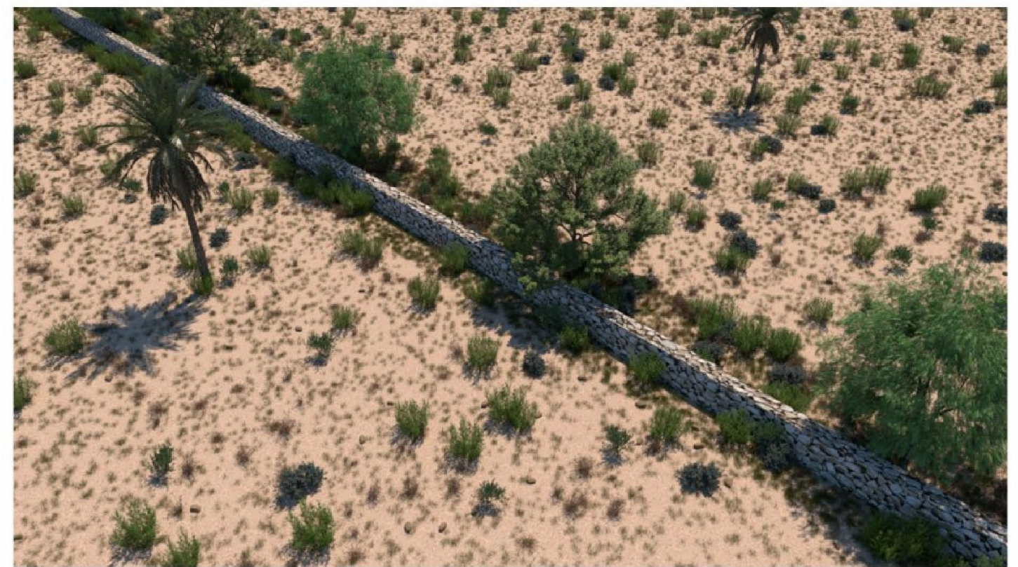
Planta A.2.1.: Vista en planta de muro de piedra en seco que dispondrá de banda de vegetación de 4 m aguas arriba y 2 m aguas abajo
