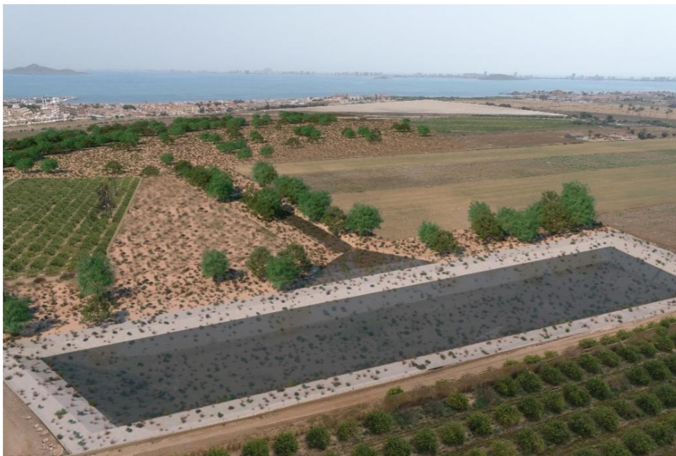
Ilustración 14: Detalle 3D del estado final de la restauración del cauce natural. La balsa mostrada en la ilustración, es una balsa existente (no incluida en el Proyecto)
