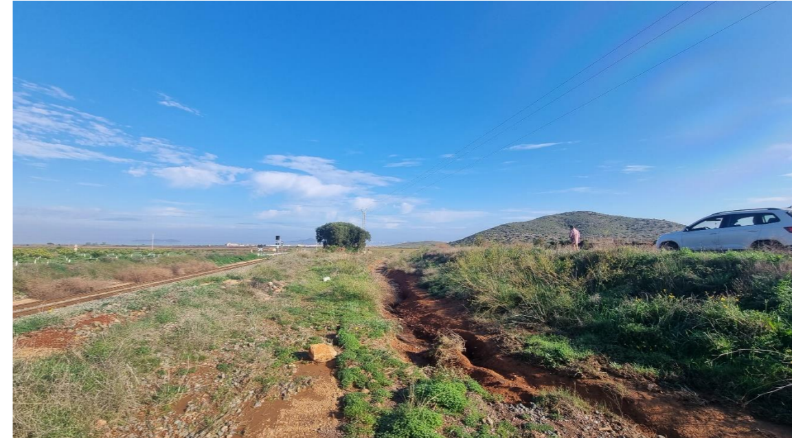
Ilustración 85: La misma canalización de agua que en la fotografía anterior, pero aguas abajo, discurriendo paralela a la vía del F.E.V.E.
