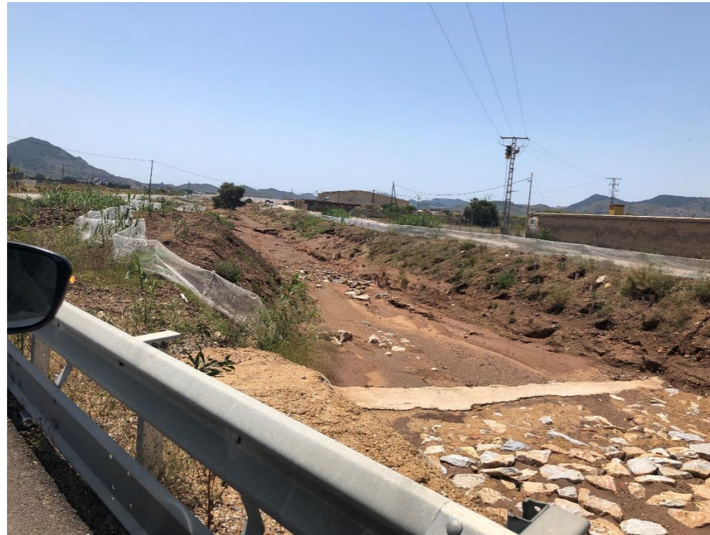
Ilustración 95: Rambla de La Carrasquilla en el punto de cruce con la carretera RM-F54.
