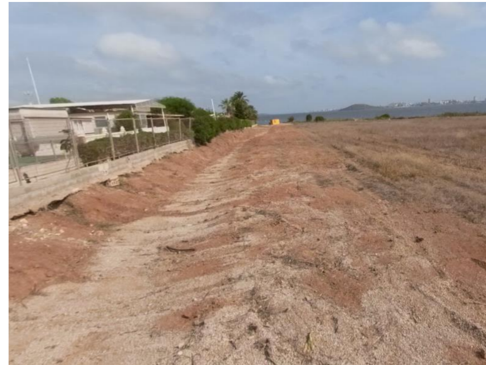
Ilustración 31: Canal de desagüe que discurre por el lateral del Camping Caravanning Capfun La Manga, en los terrenos comprendidos entre el camping y Playa Honda. El canal desemboca directamente en el Mar Menor.
