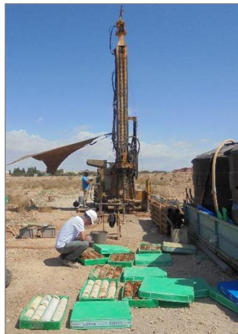
Figura 31. Imágenes de la construcción de los sondeos litológicos
