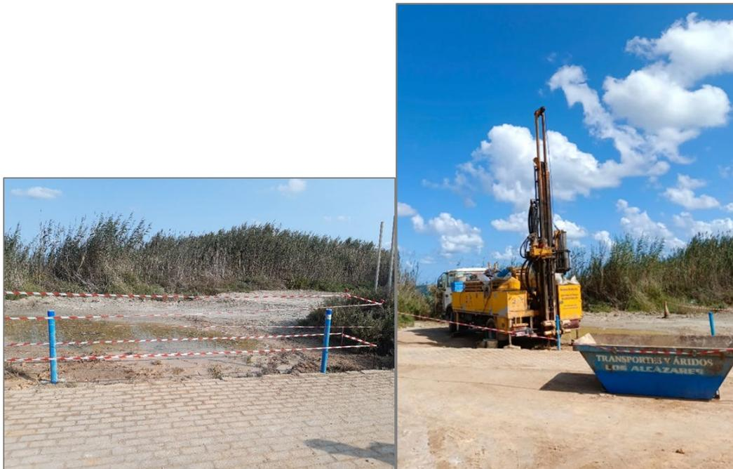
Figura 41. Construcción de los nidos de piezómetros en el humedal de La Hita.
