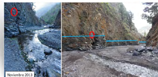
Imágenes comparativas noviembre 2013 – diciembre 2013: señalado en rojo el punto de anclaje de la cruz en memoria de la víctima de la riada de 2001. Líneas azules imagen derecha: nivel de máxima crecida de las lluvias torrenciales del 11 de diciembre de 2013.
