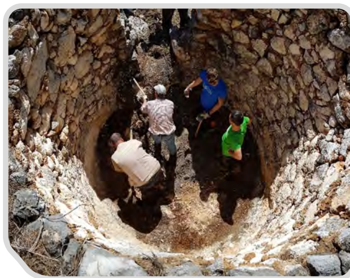
Fotografía 37. Recuperación de antigua alberca de riego (Salvador Caracuel)
