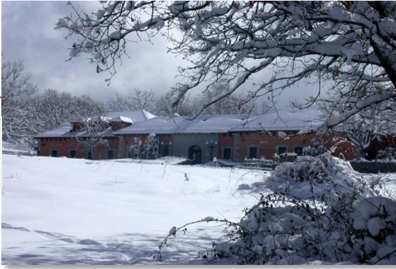
Edificio del CENEAM
