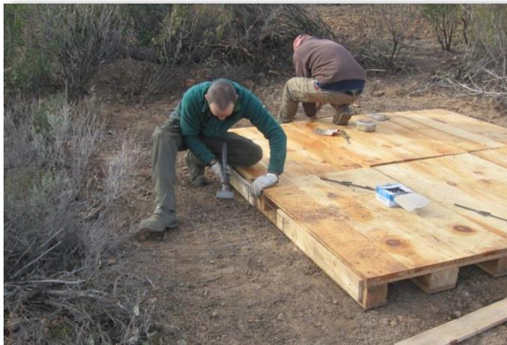
Construcción de vivares, P.N. de Cabañeros
