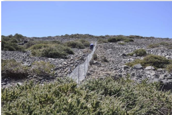
Ejecución de vallado de protección, P.N. Caldera Taburiente
