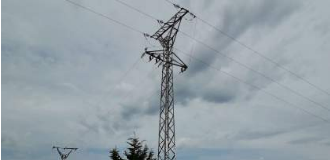
Foto 1: Apoyo A24933 dentro de la zona de Dominio Público Marítimo-Terrestre.
