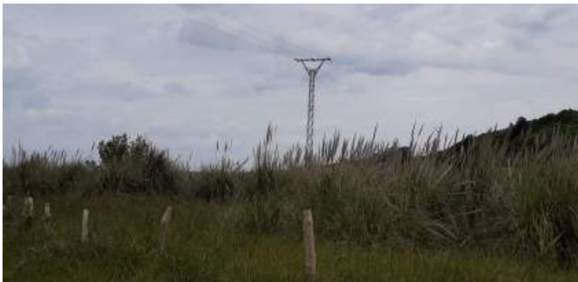
Foto 5: Apoyo AV83258 dentro de la zona de Dominio Público Marítimo-Terrestre.
