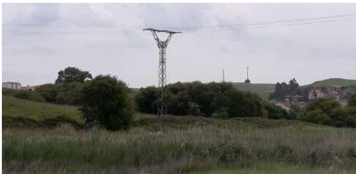
Foto 6: Apoyo A24908 dentro de la zona de Dominio Público Marítimo-Terrestre.
