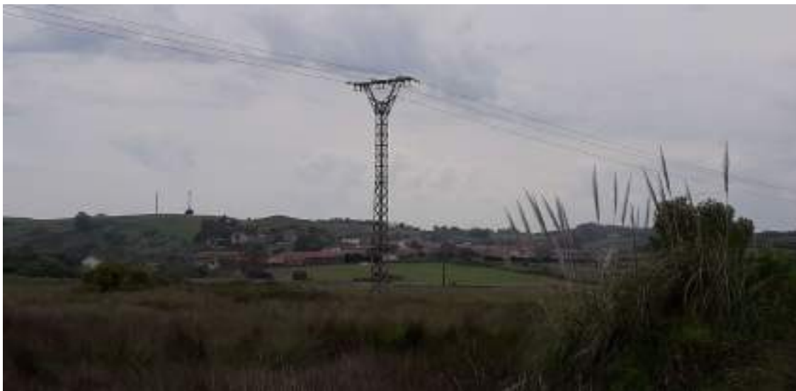
Foto 7: Apoyo A39432 dentro de la zona de Dominio Público Marítimo-Terrestre.
