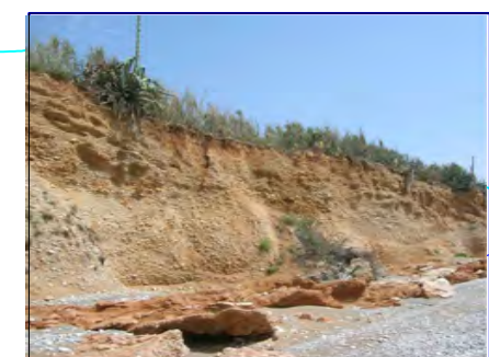
DESCRIPCIÓN: CUATERNARIO: UNIDAD Q PL - TALUD COMPUESTO POR GRAVAS Y BOLOS SUBREDONDEADOS EN MATRIZ LIMOARCILLOSA CON INDICIOS DE ARENA MUY FINA, CON CEMENTACIÓN IRREGULAR. - ESTADO DENSO Y COLOR MARRÓN ANARANJADO (PLIOCUARTERNARIO) * A TECHO COBERTURA VEGETAL. - A BASE DEL TALUD, ESTÁ FUERTEMENTE CEMENTADO FORMANDO UN CONGLOMERADO DE COLOR MARRÓN ROJIZO.
