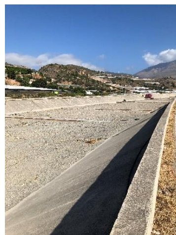
Tramo de rambla
