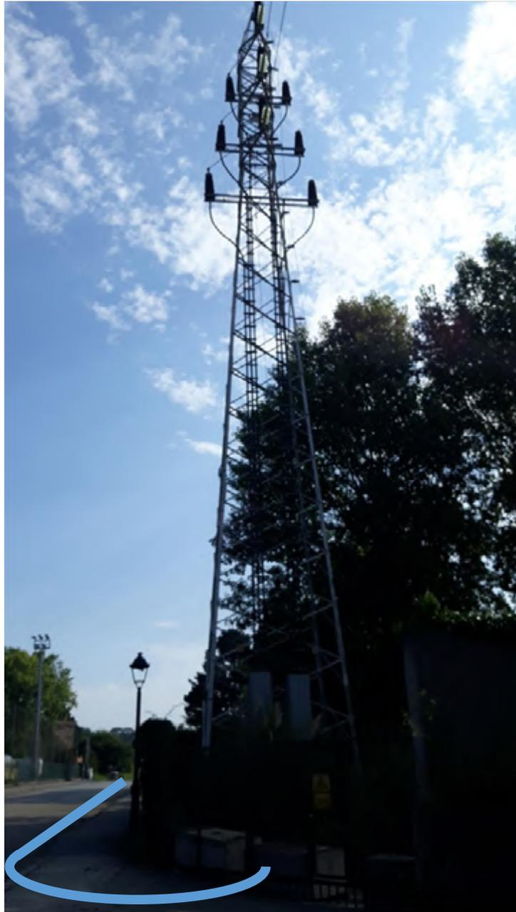
**Foto 1: Apoyo de conversión aéreo-subterránea existente a sustituir cables subterráneos y conexiones, y vial público por el que se plantea la canalización proyectada. Avda. Juan Carlos I.**
