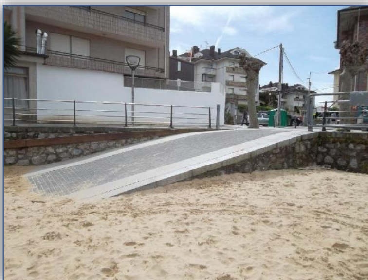
Detalle Rampa actual de acceso a vehículos
