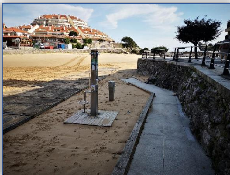
Servicios de duchas y Lavapiés existentes en zona Rampa
