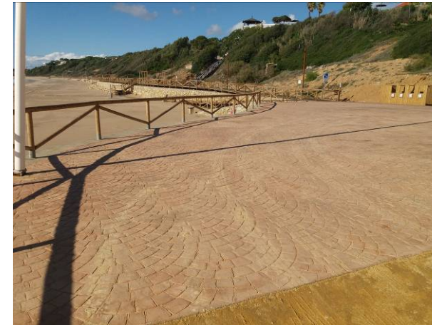
Rampa acceso a playa para personas con movilidad reducida (en 0+000)
