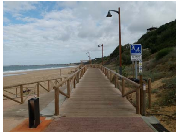
Fin sendero peatonal existente entre Fuentebravía y las Redes
