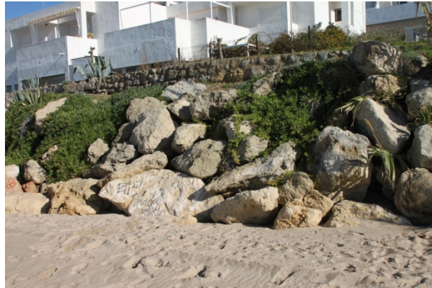
Estado actual del muro de escollera a rehabilitar
