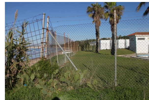
Desmontaje y reposición de valla de cerramiento en antigua depuradora
