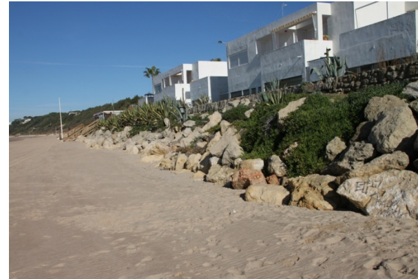
Estado actual del muro de escollera a rehabilitar
