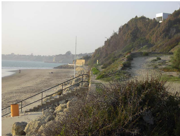
FOTO N° 2: Vista panorámica desde la cata C-3 hacia el NO.
