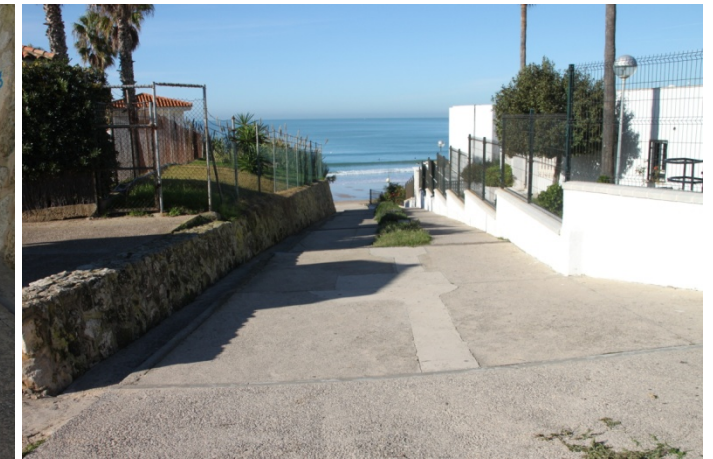
Inicio rampa descenso a playa desde calle Mar Adriático
