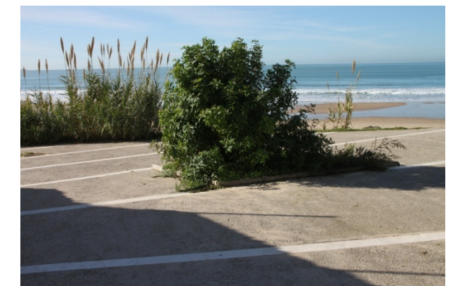
Demolición de pavimento y bordillos en tramo 0+170 a 0+190
