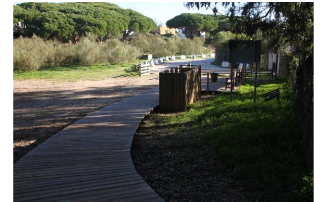
0+770, conexión del nuevo sendero con rampa existente de acceso a playa
