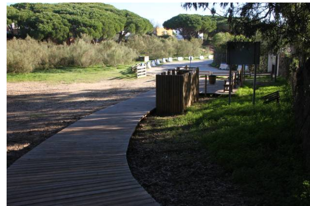
0+770, conexión del nuevo sendero con rampa existente de acceso a playa
