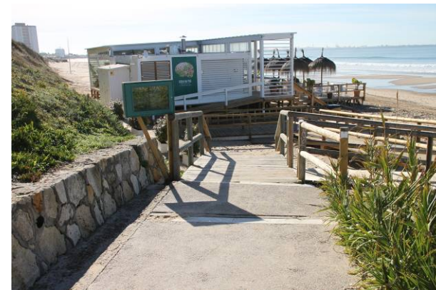
Rampa acceso a playa para personas con movilidad reducida (0+190)
