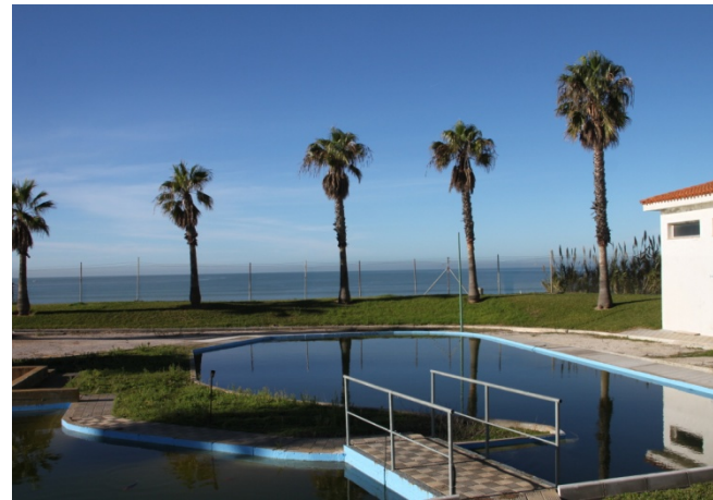
Interior instalaciones actuales de depuradora (sin uso)
