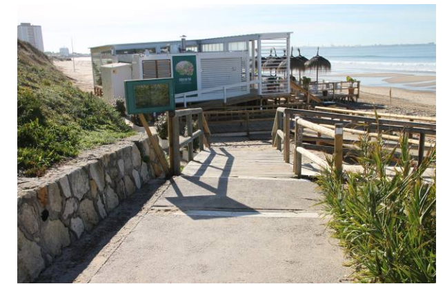
Rampa acceso a playa para personas con movilidad reducida (0+190)
