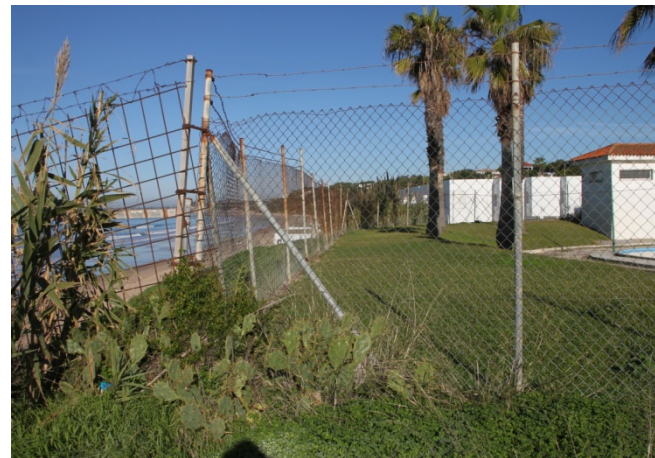
Vista en eje 0+260 sentido Norte
