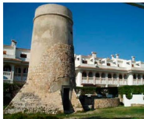
Figura 65. Torre de La Almadraba.
