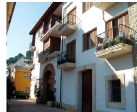
Figura 70. Almacenes portuarios Puerto de Denia.
