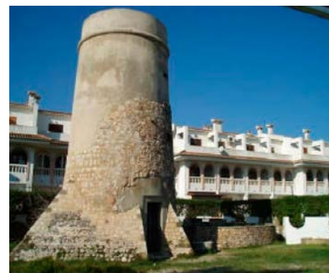
Figura 10. Torre de La Almadraba.
