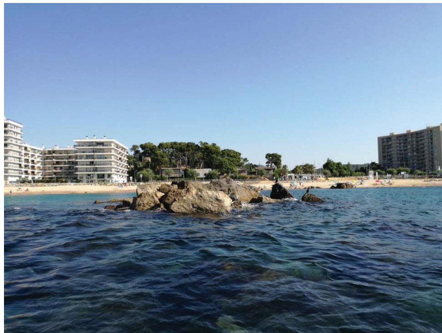
VISTA ZONA DIQUE
