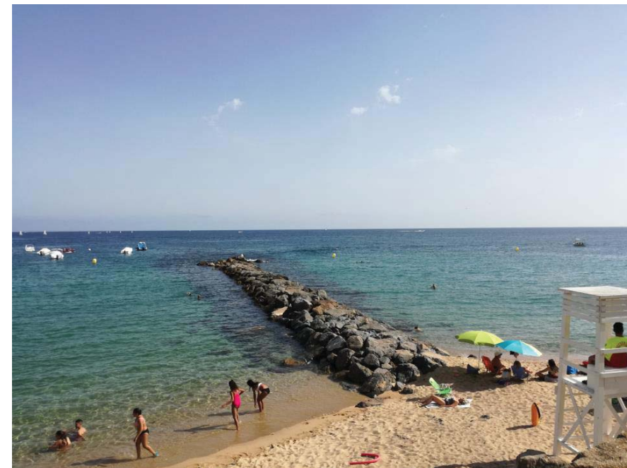
VISTA ZONA DIQUE
