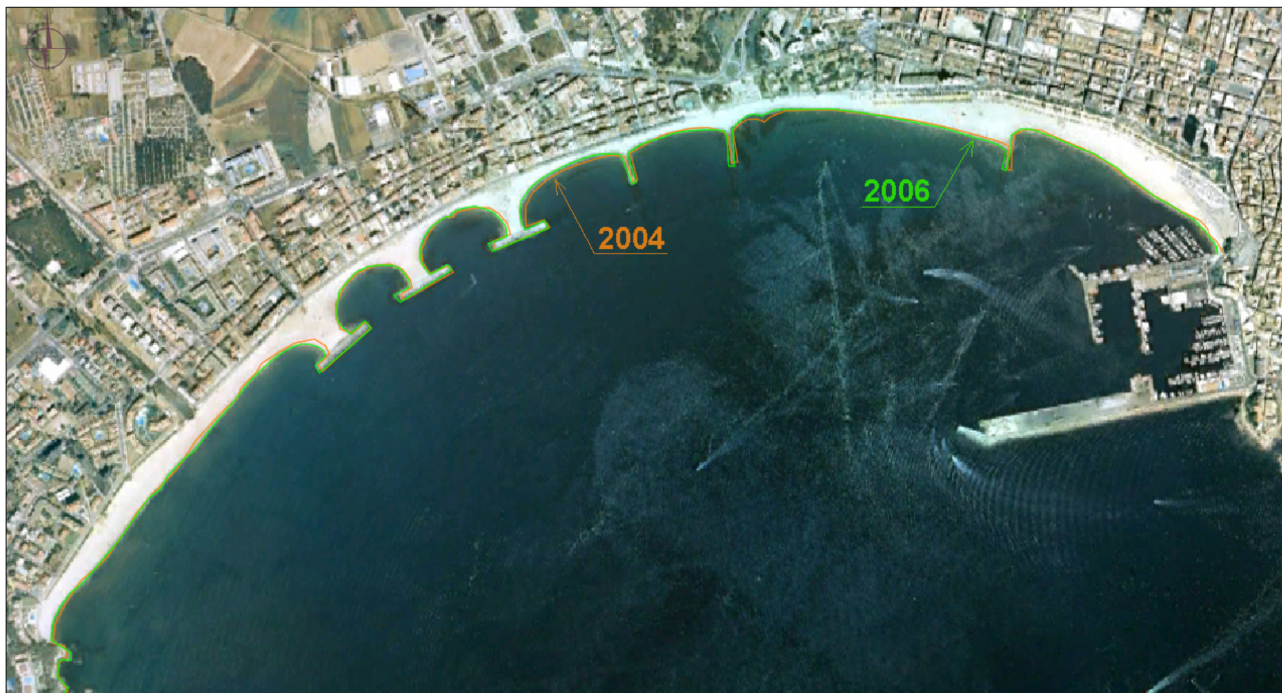
Figura 5.3. Líneas de costa de los años 2004 y 2006.
