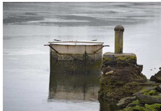
Registro del emisario, localizado en frente del área de actuación.
