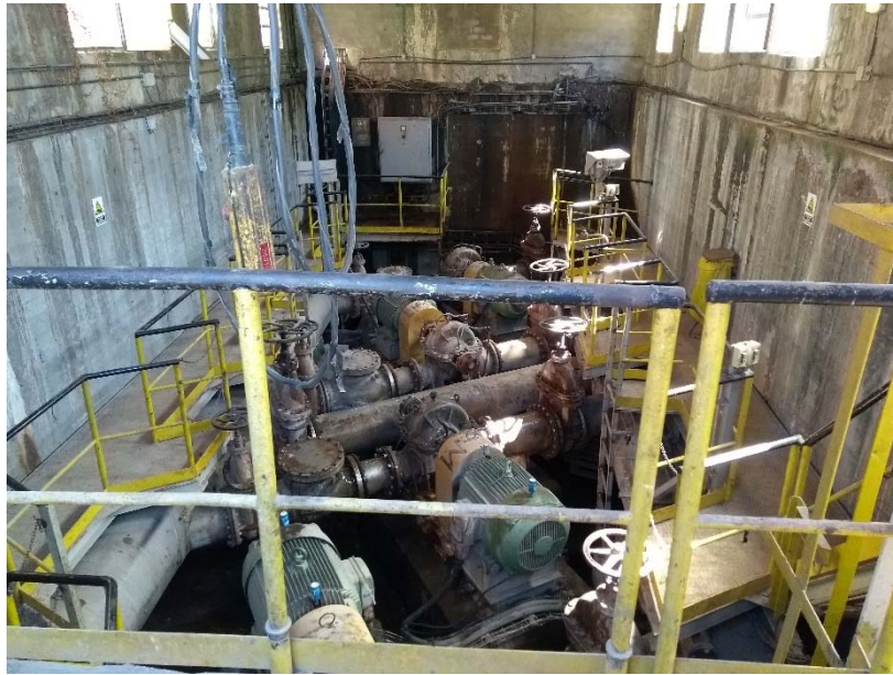
Estación de bombeo actual en salida de Planta de CEASA (julio 2019).
