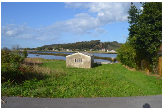
Zona de la actuación de la Parcela.
