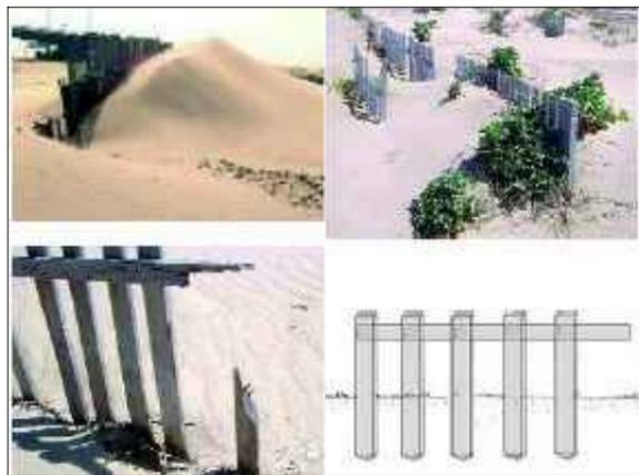
DETALLE CAPTADOR DE MADERA (TABLAESTACA) S/E
