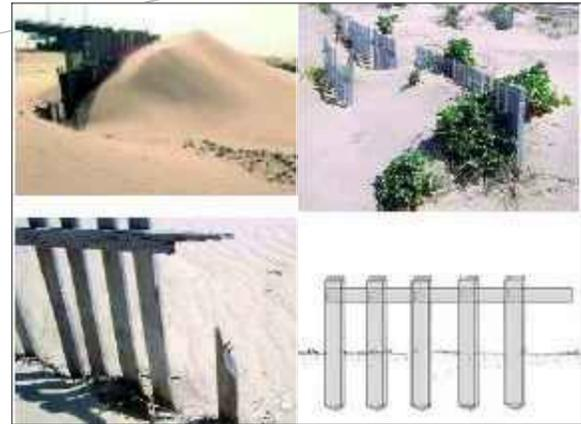
DETALLE CAPTADOR DE MADERA (TABLAESTACA)
