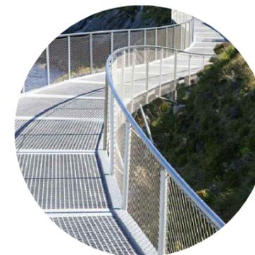
Estructura permeable tipus TRAMEX
