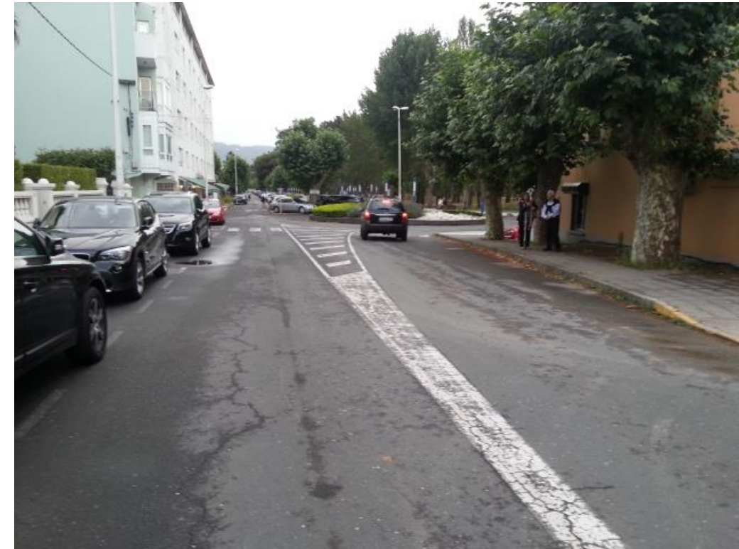
FOTO 3. Tramo inicial colector Cabañas colector C1 PRFV Ø500
