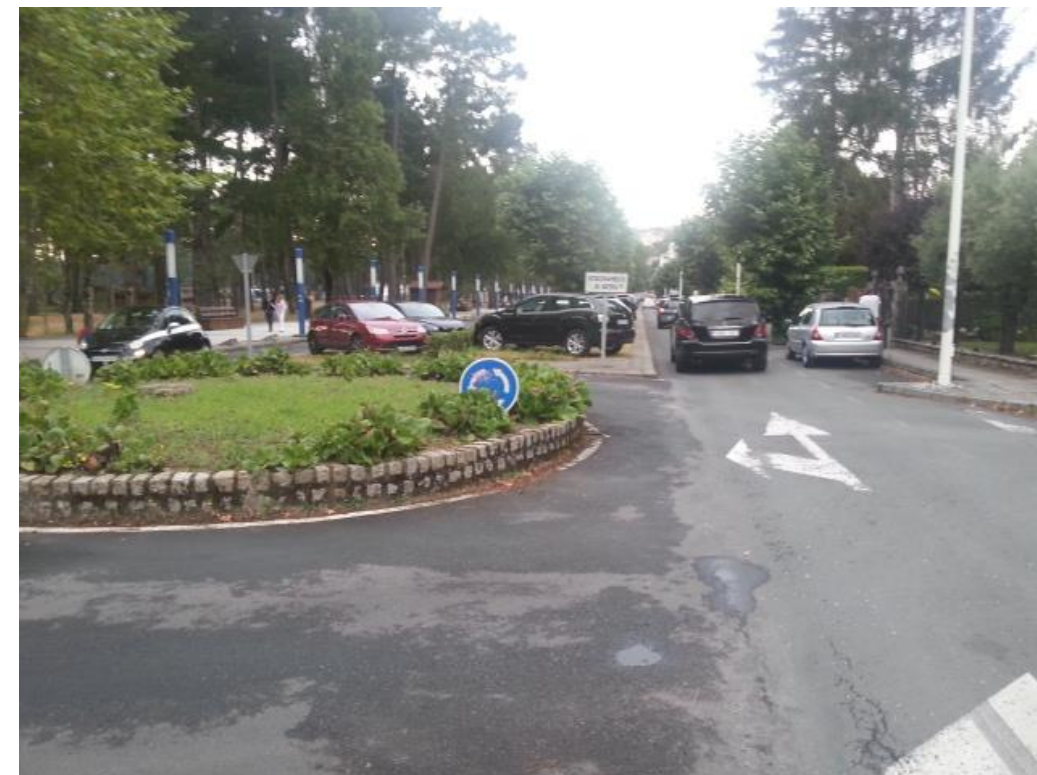
FOTO 8. Tramo colector Cabañas colector C1 PRFV Ø1000
