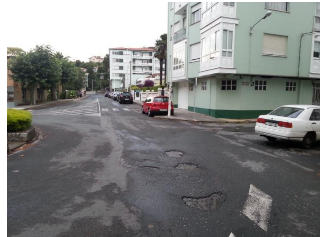
FOTO 4. Tramo por el trasdós de la playa de Cabañas. Colector C1 PRFV Ø800. Conexión colector C3.
