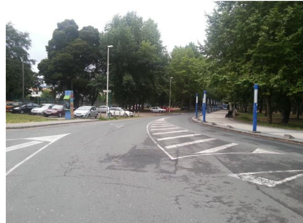
FOTO 11. Tramo colector Cabañas colector C1 PRFV Ø1000 y zona de conexión con colector C2
