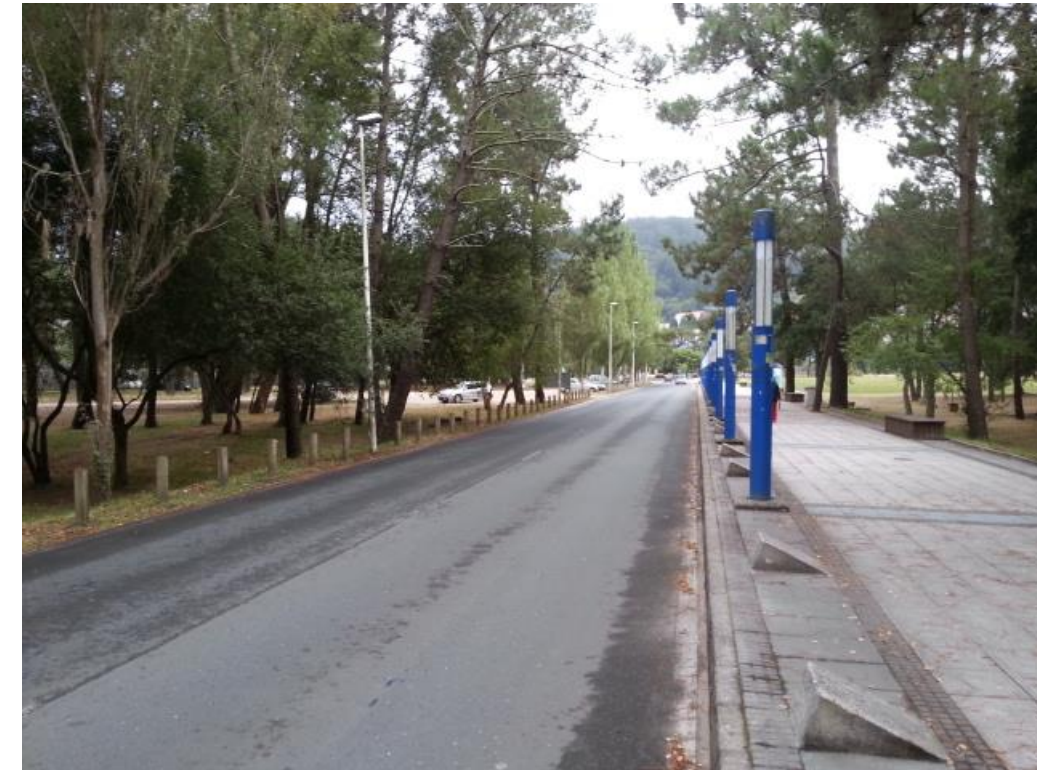
FOTO 15. Tramo colector Cabañas bajo carril próximo a paseo. Colector C1 PRFV Ø1200
