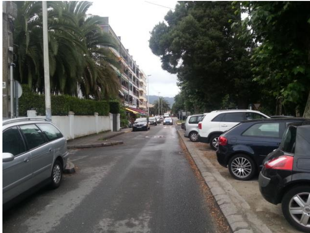
FOTO 9. Tramo colector Cabañas colector C1 PRFV Ø1000
