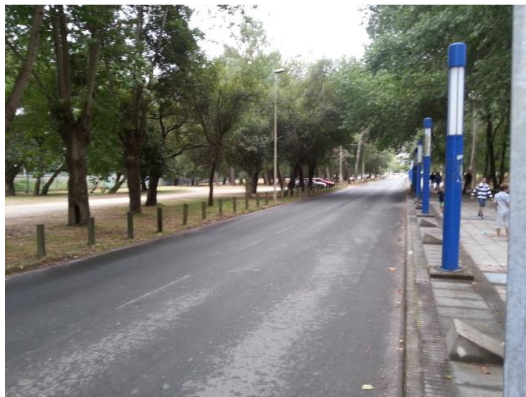
FOTO 14. Tramo colector Cabañas bajo carril próximo a paseo. Colector C1 PRFV Ø1200
