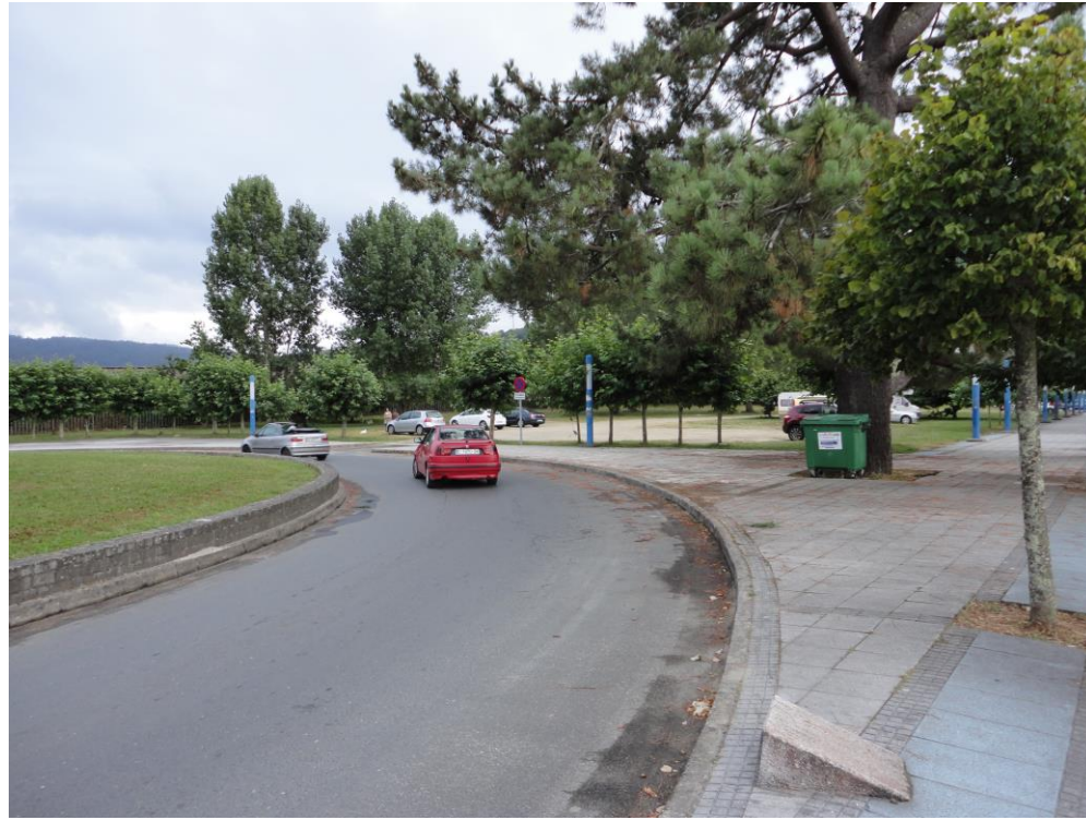
FOTO 17. Tramo de llegada del colector al tanque de retención de Cabañas. Colector PRFV Ø1200
