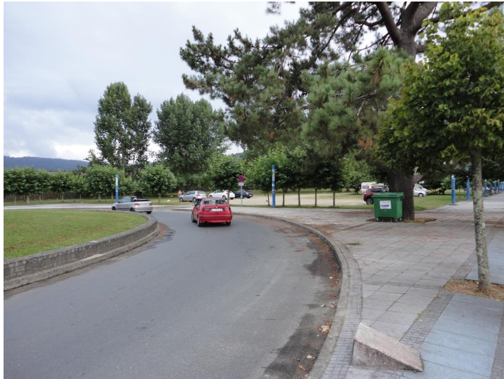
FOTO 1. Tramo de llegada del colector al tanque de retención de Cabañas. Colector PRFV Ø1200
