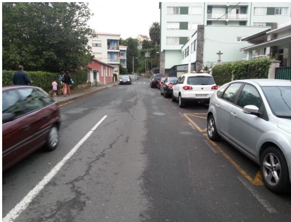
FOTO 2. Tramo inicial colector Cabañas colector C1 PRFV Ø500
