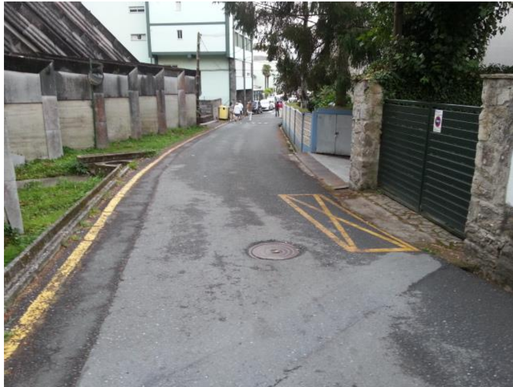
FOTO 1. Pozo de inicio colector Cabañas C1 PRFV Ø500
