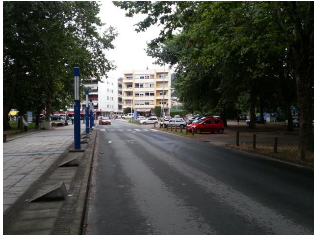
FOTO 13. Tramo colector Cabañas bajo carril próximo a paseo. Colector C1 PRFV Ø1200
