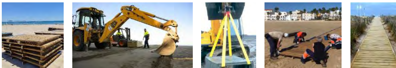
PROCESO SECUENCIAL DE MONTAJE DE LAS PASARELAS
