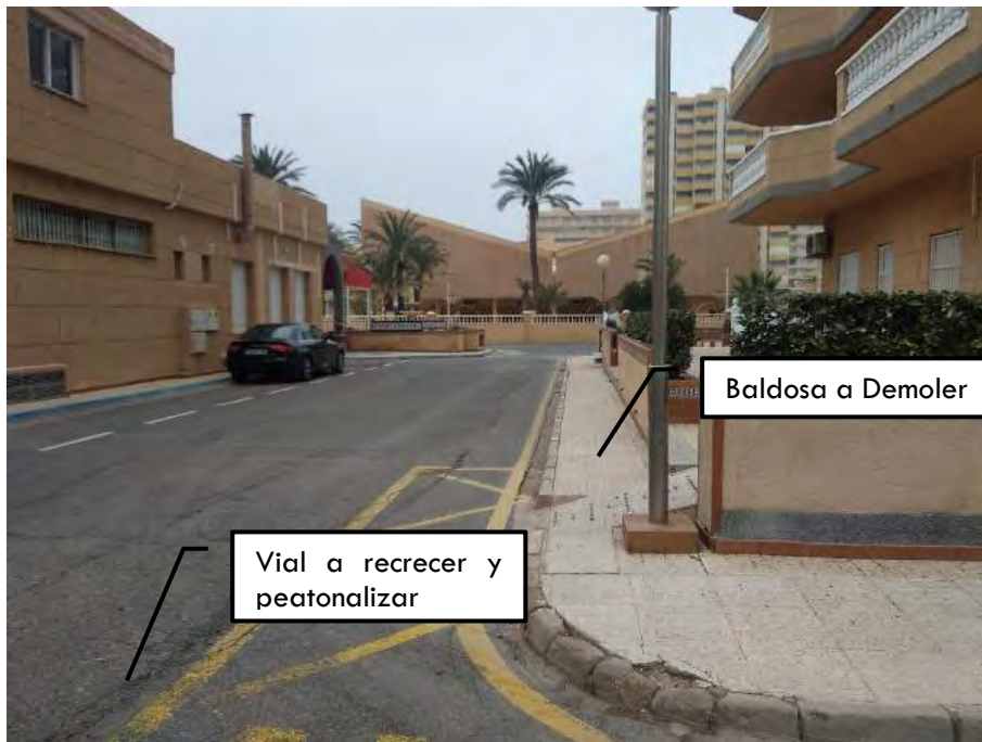
FOTOGRAFÍA N º7: Caminos entre parterres a demoler. Elementos urbanísticos a demoler.
