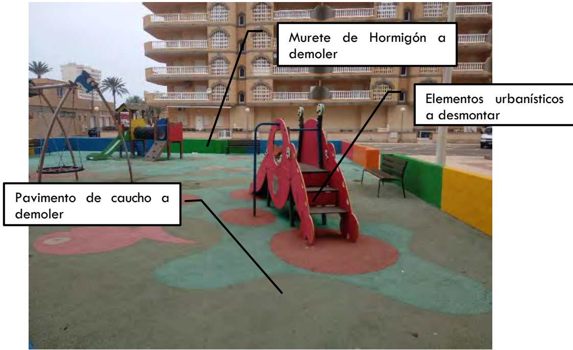
FOTOGRAFÍA N° 8: Zona de juegos a demoler
