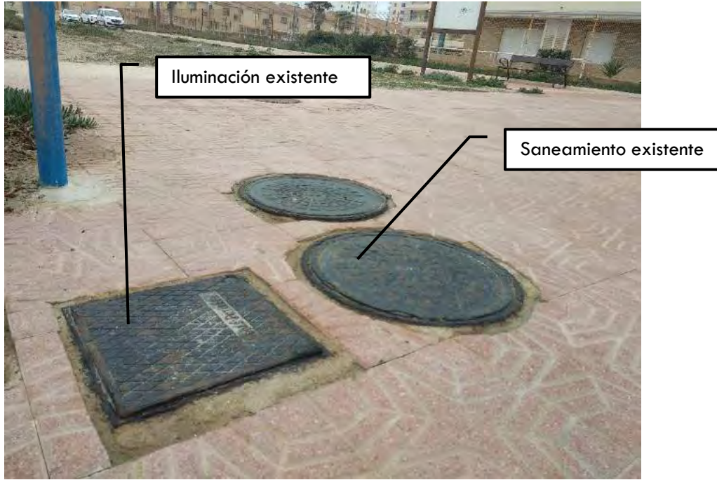
FOTOGRAFÍA N° 11: Servicios existentes. Saneamiento e iluminación
