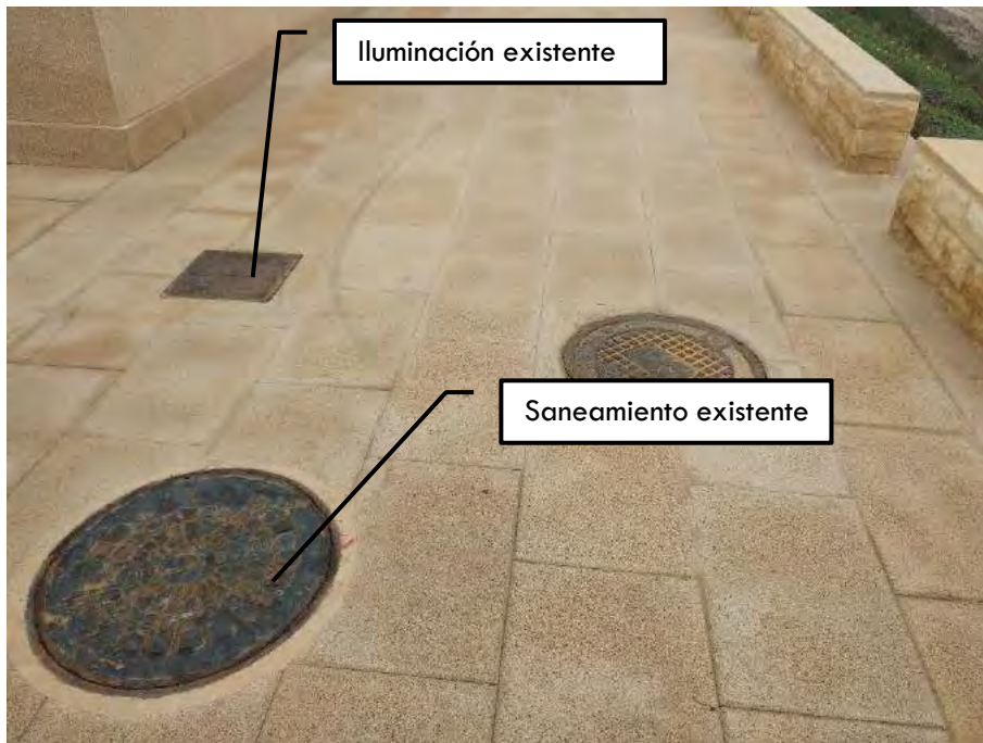
FOTOGRAFÍA N° 12: Servicios existentes. Saneamiento e iluminación
