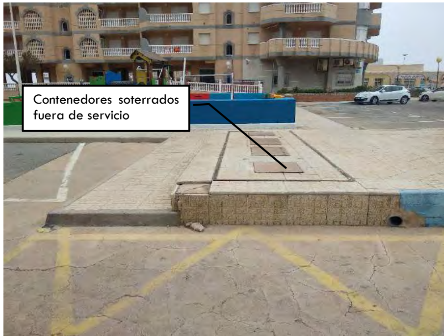
FOTOGRAFÍA N° 13: Servicios Afectados. Contenedores soterrados.
