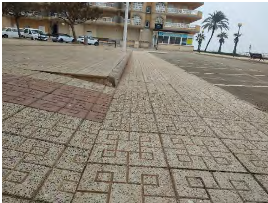
FOTOGRAFÍA N°5: Detalles pavimentación actual.
