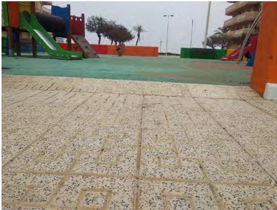
FOTOGRAFÍA N° 9: Zona de juegos a demoler. Detalle pavimentación.
