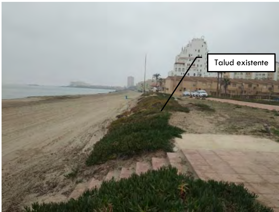
FOTOGRAFÍA N° 4: Zona de muro y graderío.
