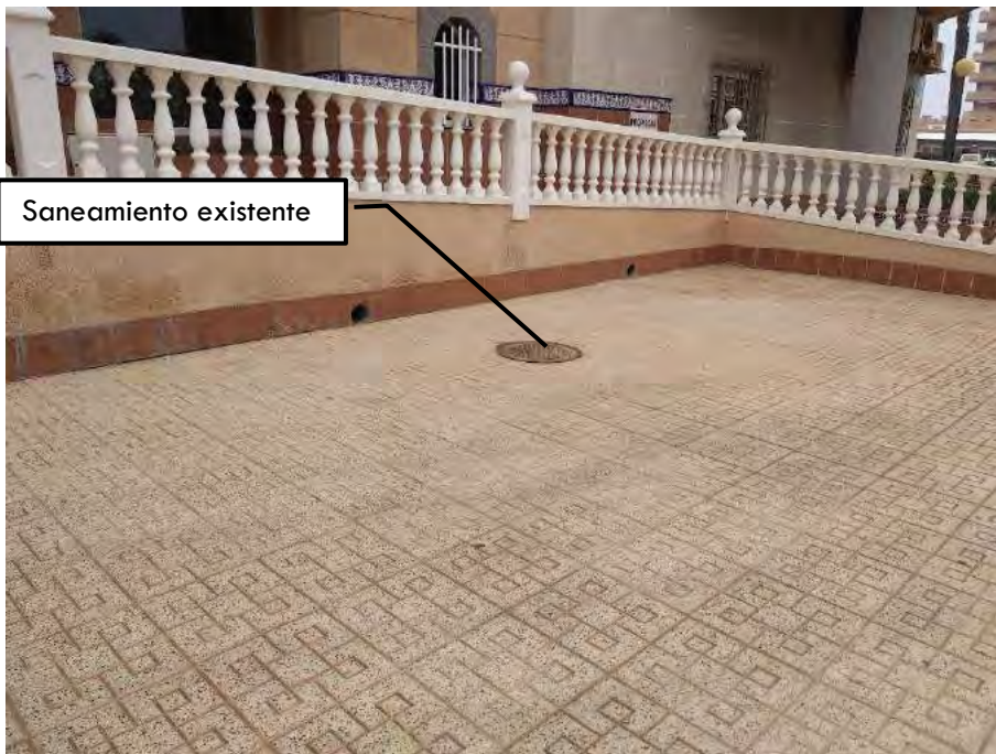
FOTOGRAFÍA N° 11: Servicios existentes. Saneamiento.
