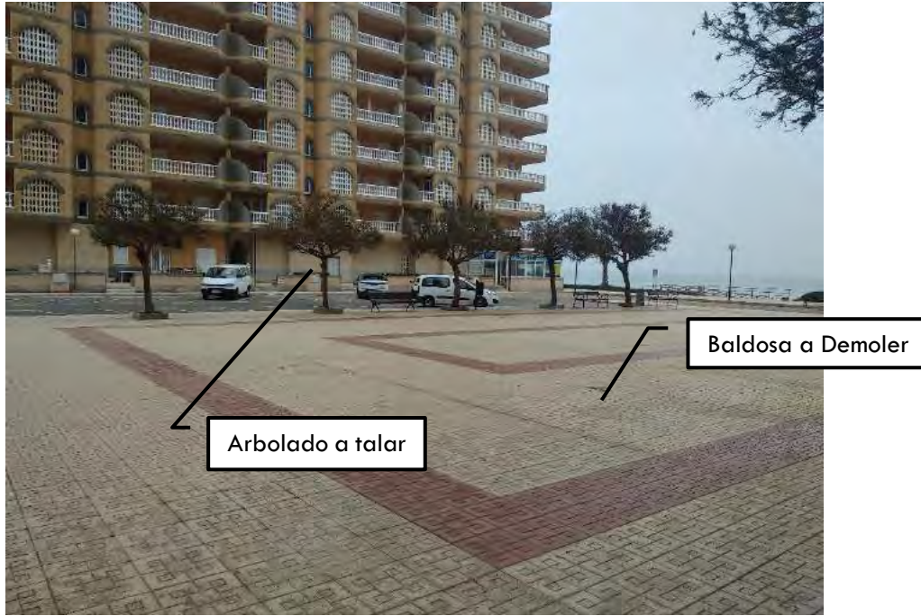
FOTOGRAFÍA N°4: Arbolado a trasladar y/o talar. Baldosa a demoler
