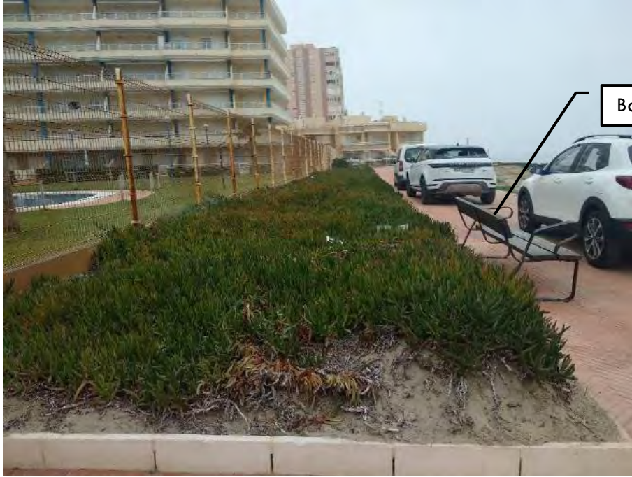
FOTOGRAFÍA N° 9: Parterre a demoler y elementos urbanos a retirar.
