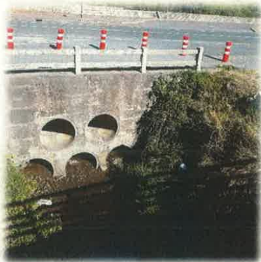
Imagen 33: Estado de los tubos arroyo Juanes aguas abajo de carretera BI-3797.
