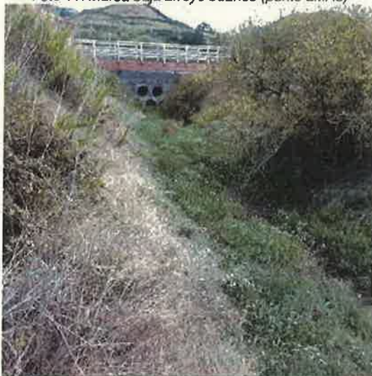
Foto 13: Marea baja aguas abajo paso carretera
