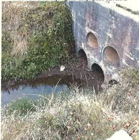
Foto 15: Marea baja aguas abajo paso carretera
