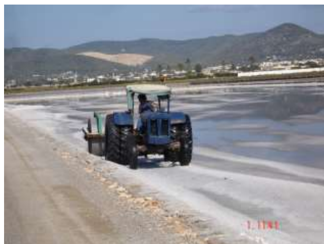
Compactación final con rulo hueco (puede llenarse de agua para aumentar su peso)
