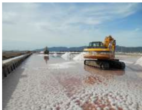
Rotura de la capa de sal mediante retroexcavadora
