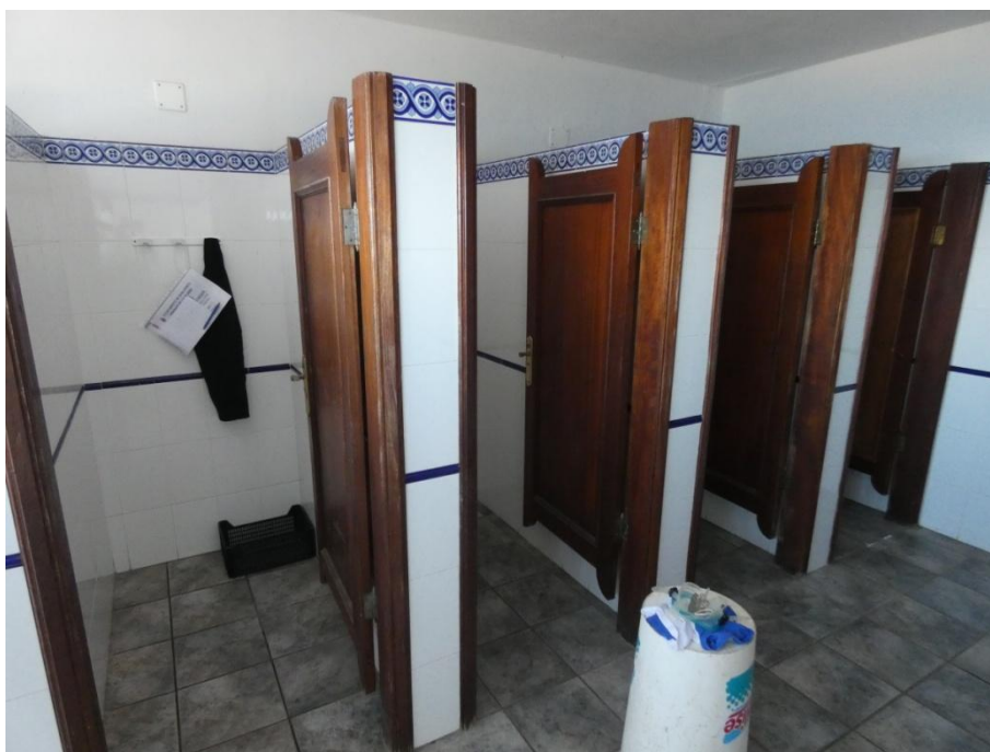
Otra vista al interior de uno de los vestuarios. Se aprecia la falta de mantenimiento, principalmente en la carpintería.
