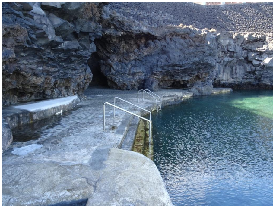
Vista detallada a uno de los accesos a la piscina nº I. Se aprecia una escalera de acero galvanizado, tipo piscina, mientras que existe otra de escalones de cemento con barandillas de acero galvanizado.
