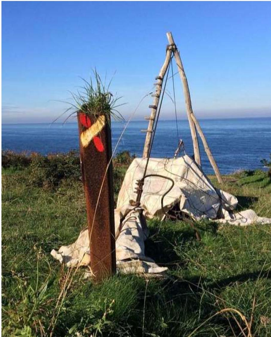
Punto final del cable guía fuera de la zona de Dominio Público Marítimo Terrestre (DPMT) tras la estructura de madera nº 3, anclado en un perfil tubular de acero laminado.
