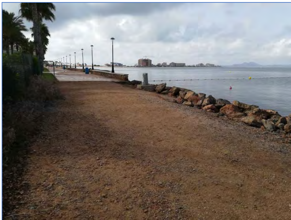
Imagen 28. Conexión de paseo marítimo ejecutado y zona de paseo a continuar
