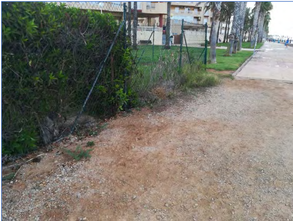
Imagen 1. Vista de la zona de paseo marítimo a actuar y enlace con el paseo pavimentado
