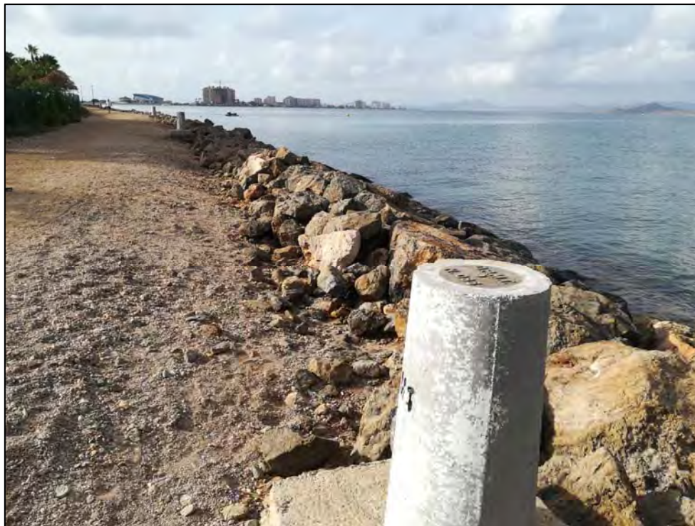
Imagen de la alineación de los muretes que delimitan la zona de DPMT.
