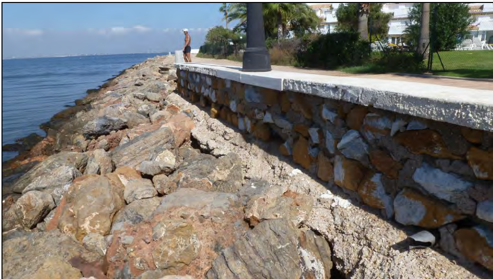
Fotografía nº 4.- Muro lateral del paseo marítimo apoyado en la escollera.
