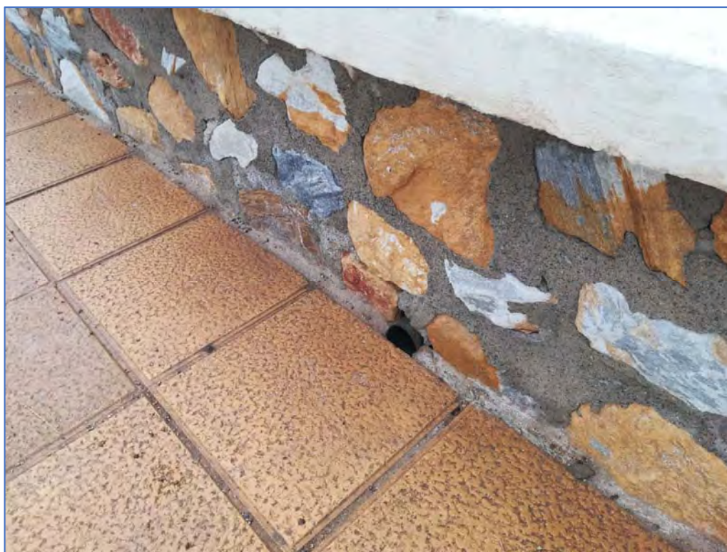
Imagen 27. Detalle de drenaje de pluviales en paseo ejecutado
