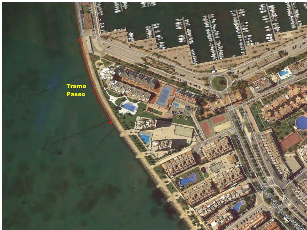
Figura nº 1.- Vista aérea del paseo marítimo (google earth).
