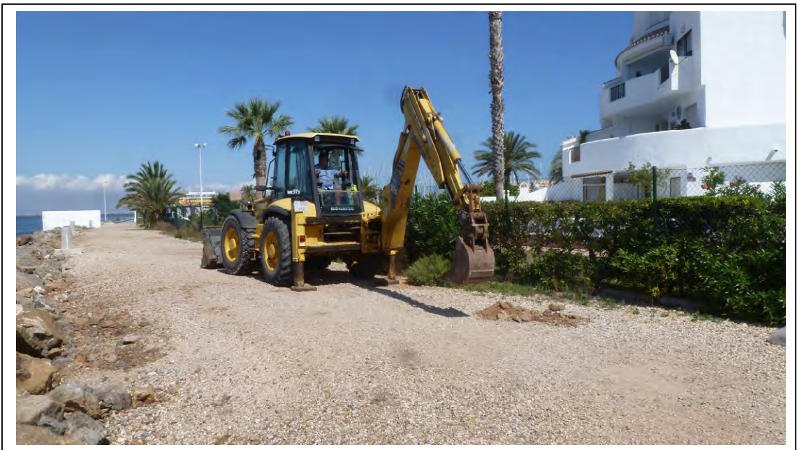
Fotografía nº 4: Retroexcavadora excavando la calicata C-1.
