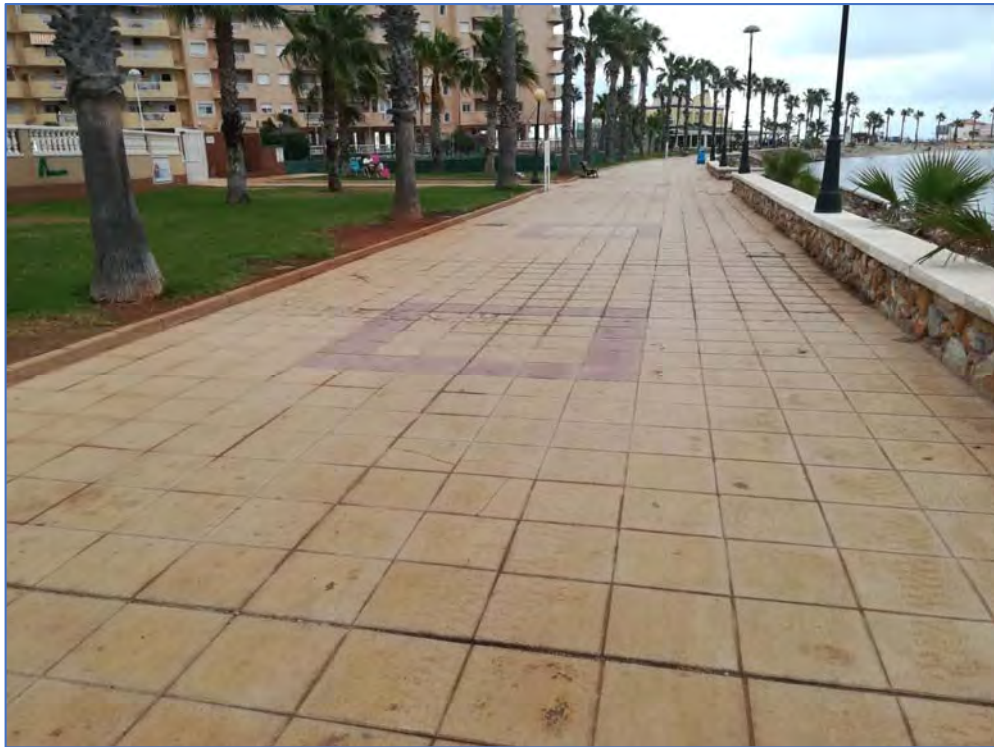
Imagen 24. Vista general del paseo marítimo ejecutado
