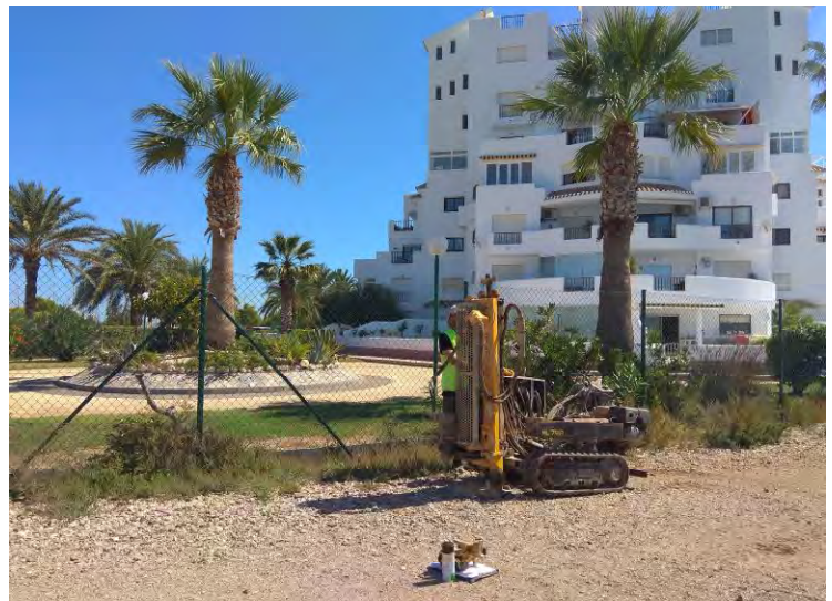
Fotografía del ensayo de penetración dinámica
