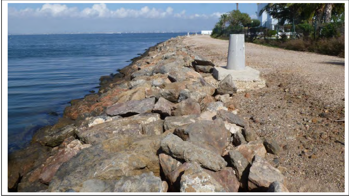
Fotografía nº 5: Bloques de escollera visibles en el lado exterior del paseo marítimo.
