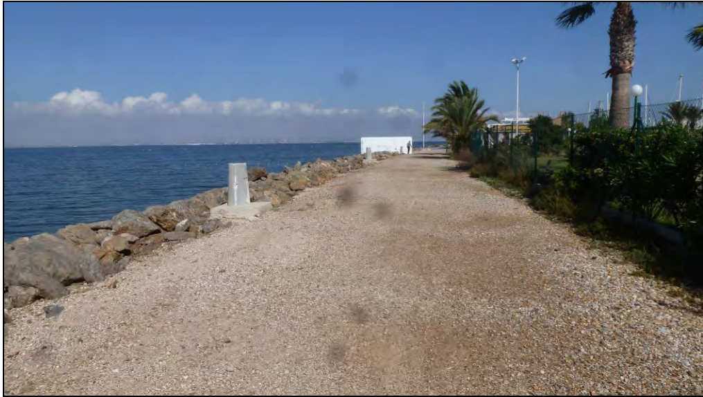
Fotografía nº 1.- Vista general del Paseo Marítimo de Poniente afectado por el proyecto.
