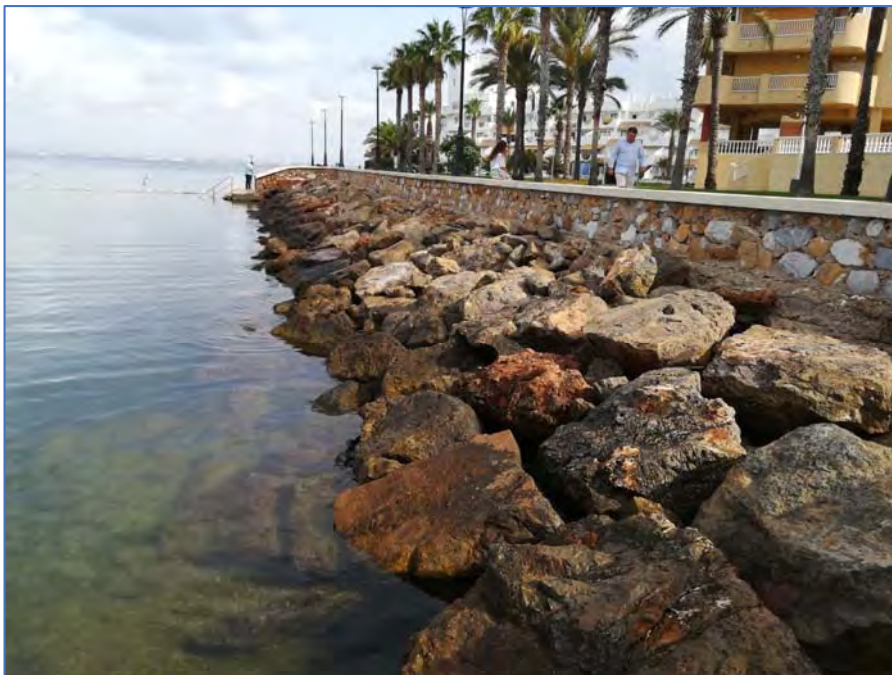
Imagen 26. Vista general de terminación de muro con escollera en paseo marítimo ejecutado
