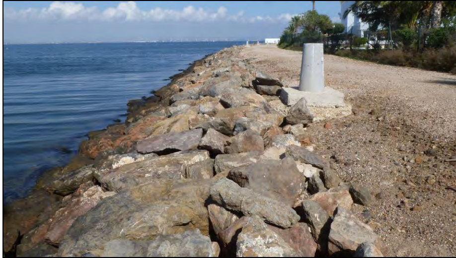
Fotografía nº 3.- Bloques de escollera visibles en el exterior del paseo marítimo.
