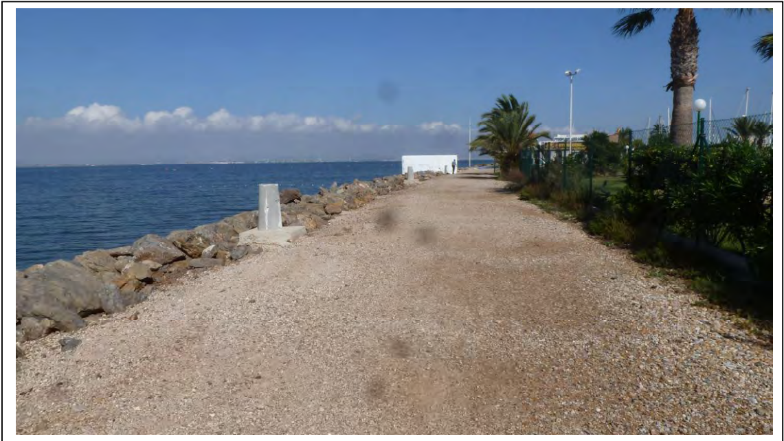
Fotografías nº 1 y 2: Vistas generales del paseo marítimo.
