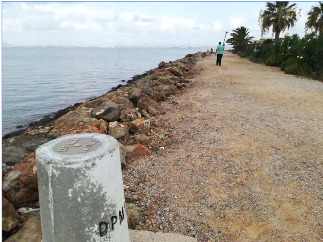
Imagen 20. Vista general de paseo marítimo a pavimentar e hito 083 del DPMT
