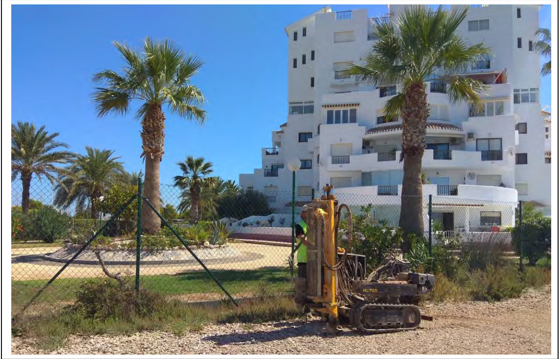
Fotografía nº 3: Maquinaria emplazada en Penetrómetro P-1.
