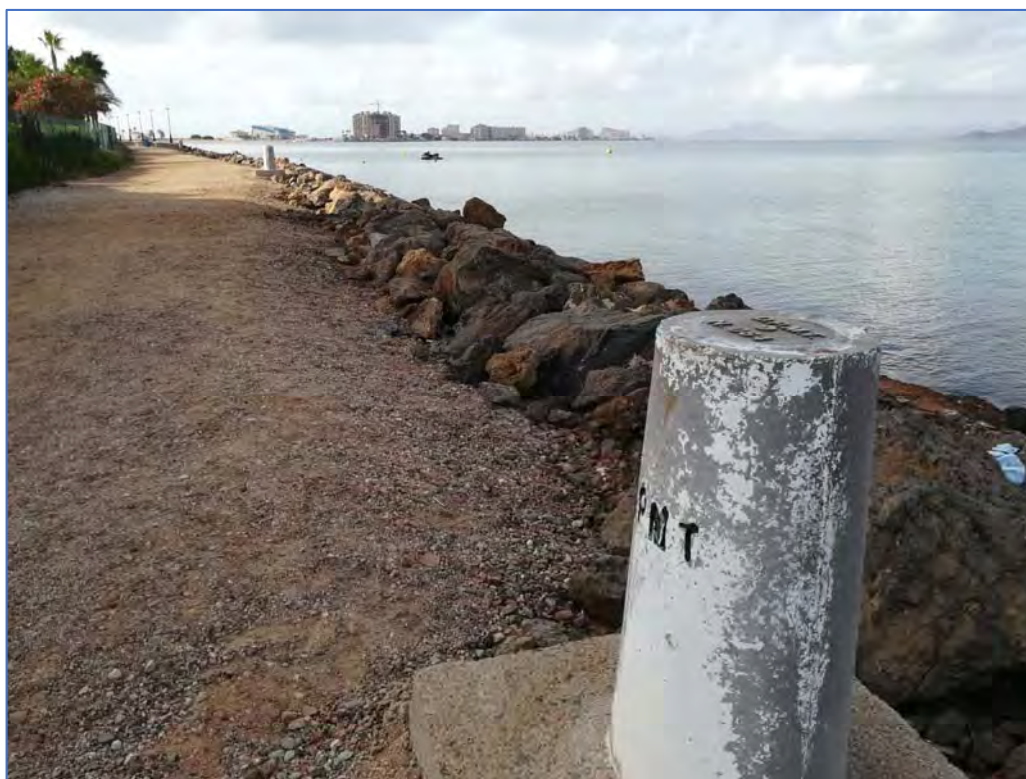
Imagen 31. Vista general de paseo marítimo de la actuación en hito 086
