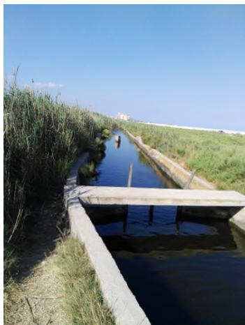
Acequia de les Piteres. Compuertas inutilizadas y con reducción de sección del canal.
