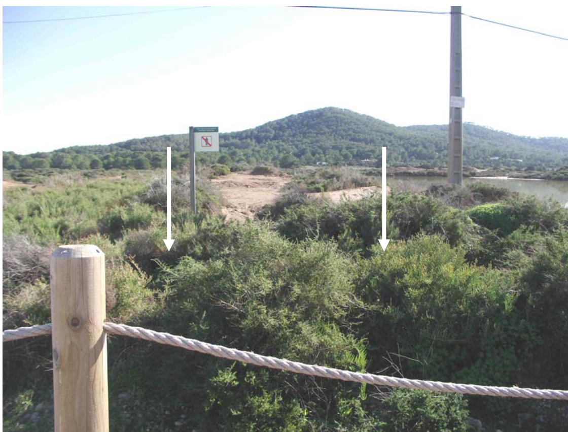
Foto 11. Emplazamiento proyectado para otra de las vallas de madera de 4 x 1,2 m. Se ve el camino que se pretende cerrar al paso peatonal. El canal de desagüe queda a la izquierda.
