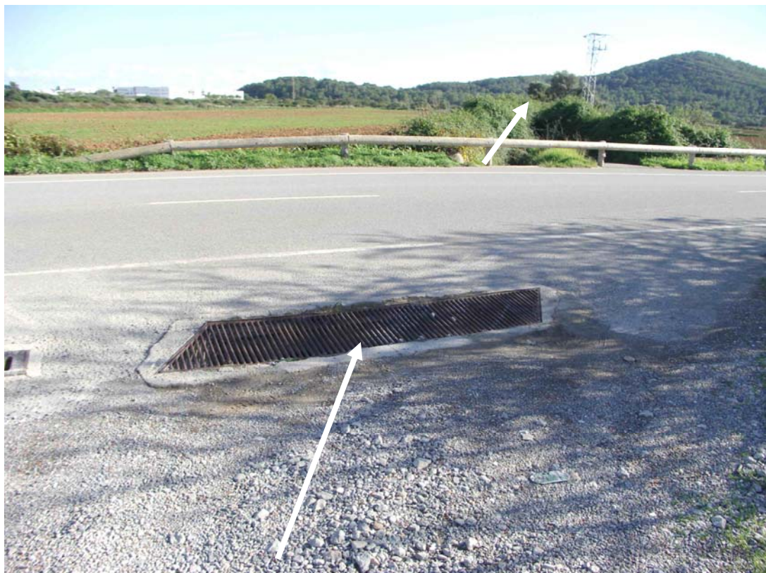
Foto 6. Obra de paso del cauce de ca na Parra bajo la carretera de la Canal .
