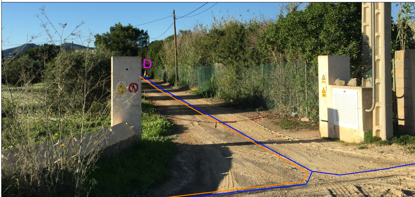
Detalle zanja por camino (f 04)
