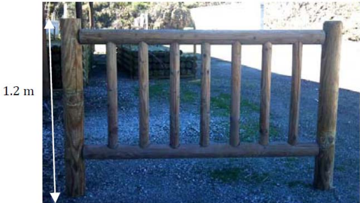
Foto 8. Diseño del vallado disuasorio de madera, como el que se colocará junto a la desembocadura del torrente en la zona húmeda de Sal Rossa .
