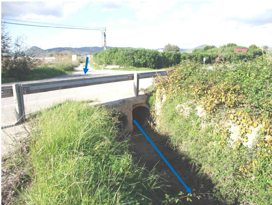
Foto 7. Obra de paso del cauce de ca na Parra bajo la carretera de la Canal .
