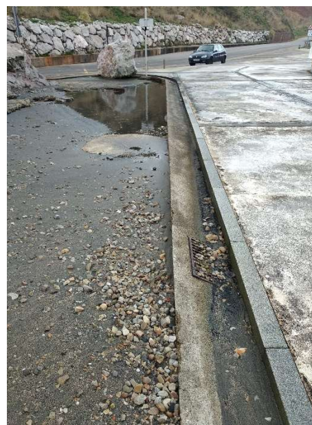
Fotografía del sumidero existente
