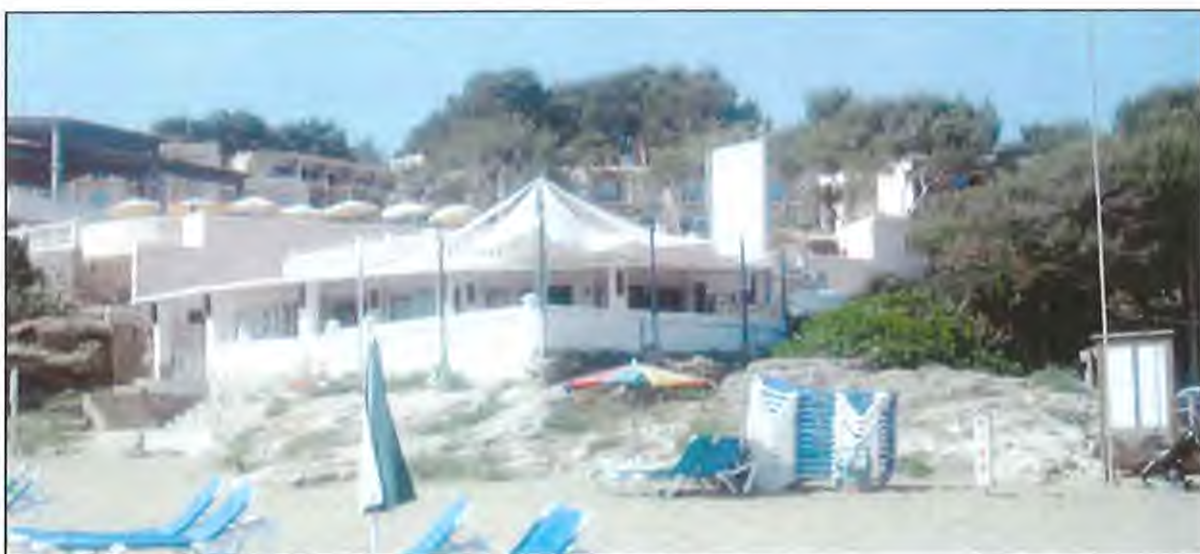
Figura 2: Vista de la edificación en zona de dominio público
