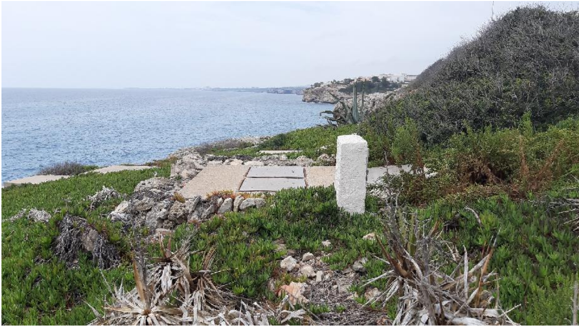
Foto Secuencia Foto: Vista norte EBAR – 1 Cala Magrana
