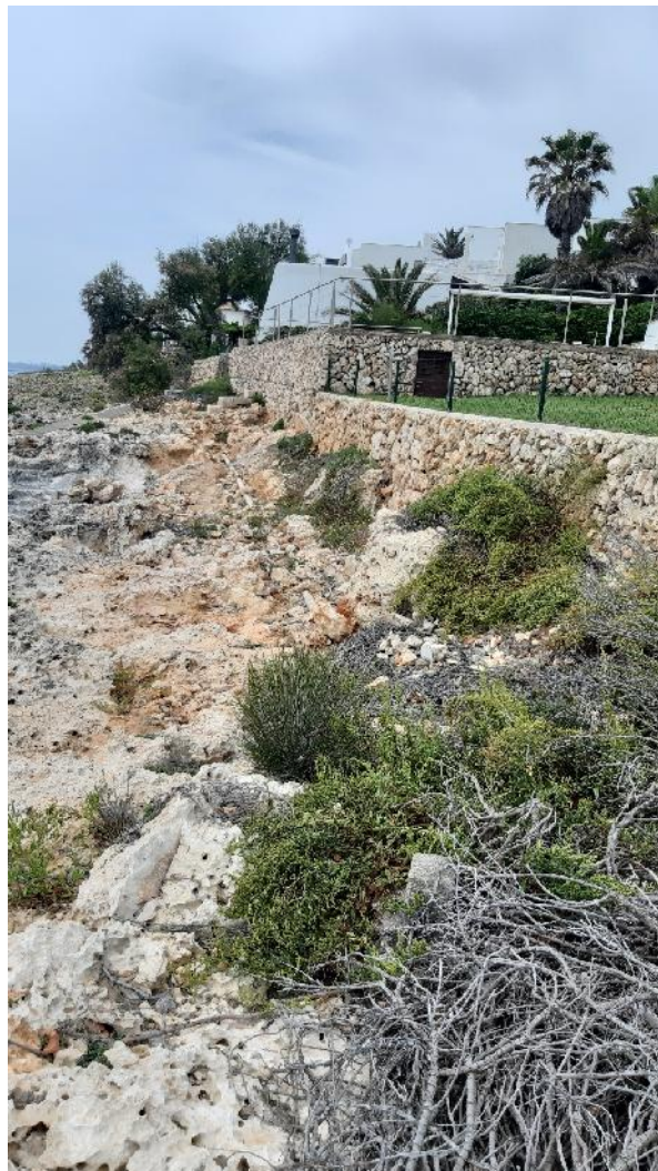
Foto Secuencia Foto: Tramo soterrado conducto impulsión
