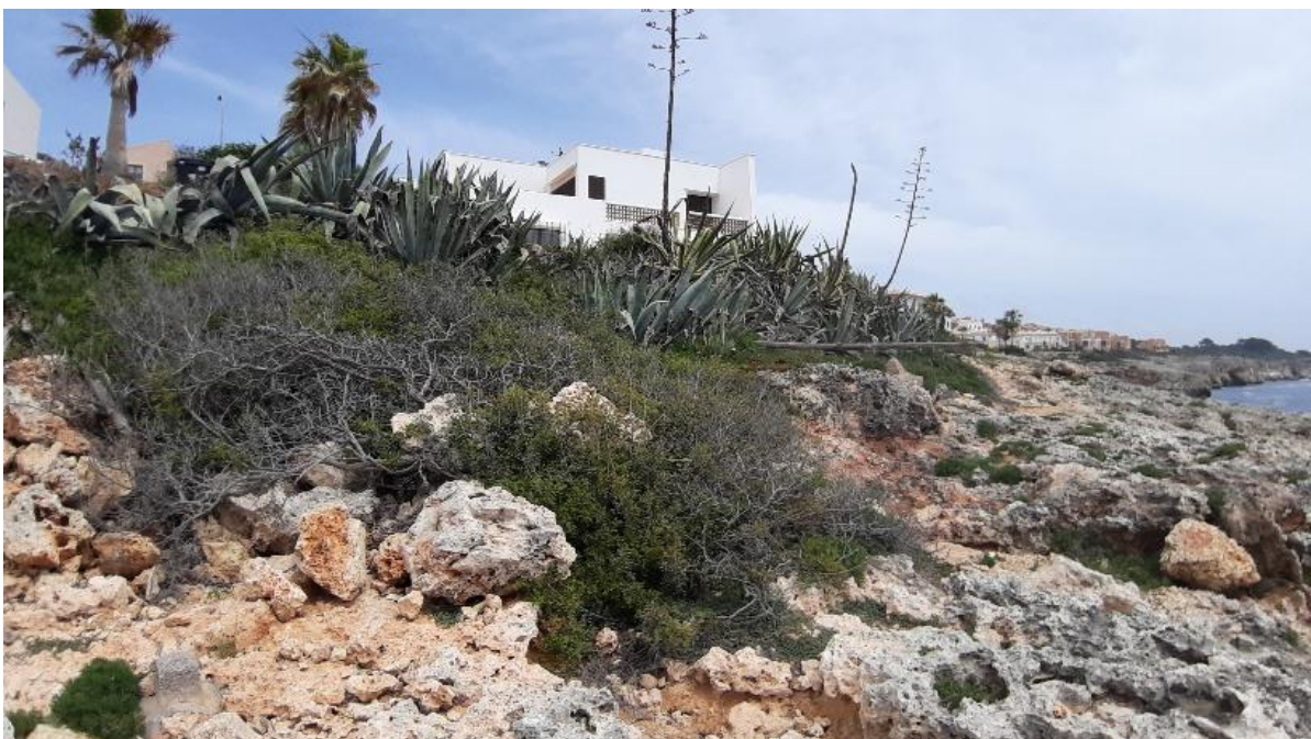
Foto Secuencia Foto: Tramo soterrado conducto de impulsión
