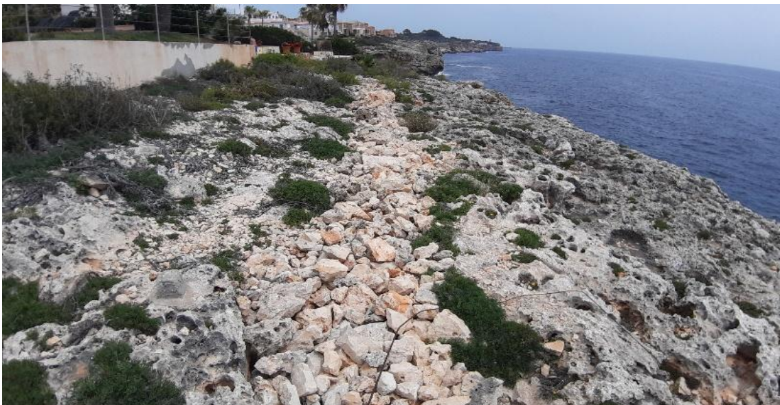
Foto Secuencia Foto: Tramo soterrado conductos afluyente e impulsión
