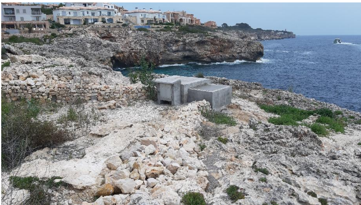
Foto Secuencia Foto: Vista general EBAR- 2 Cala Magrana
