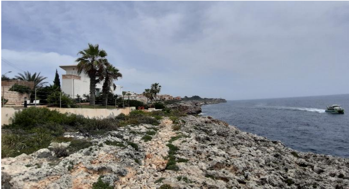
Foto Secuencia Foto: Tramo soterrado conductos afluente e impulsión
