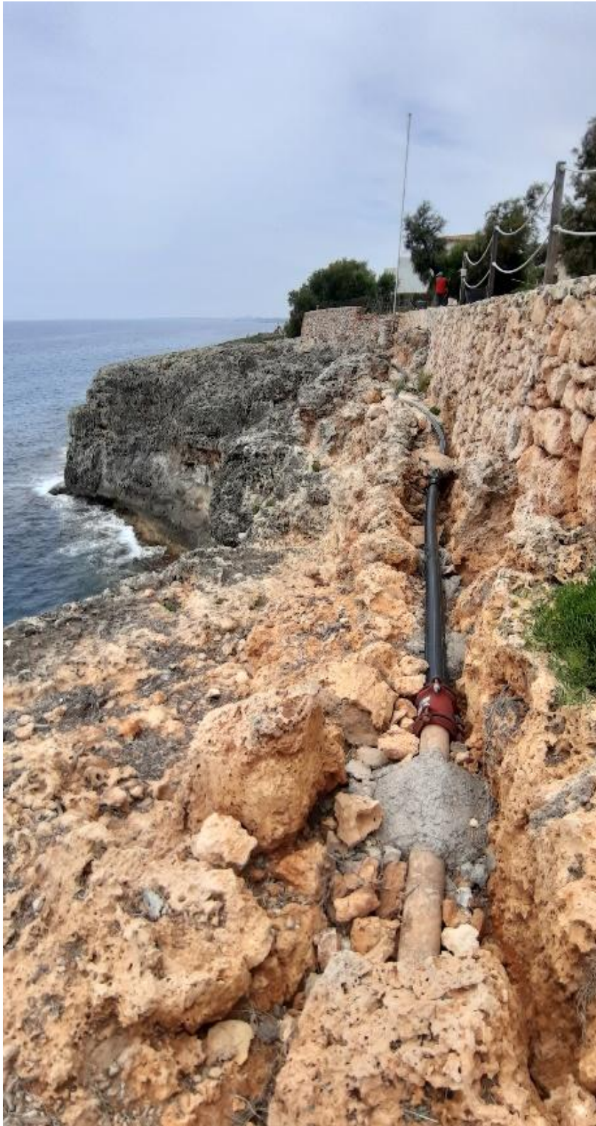
Foto Secuencia Foto: Tramo parcialmente soterrado conduito impulsión
