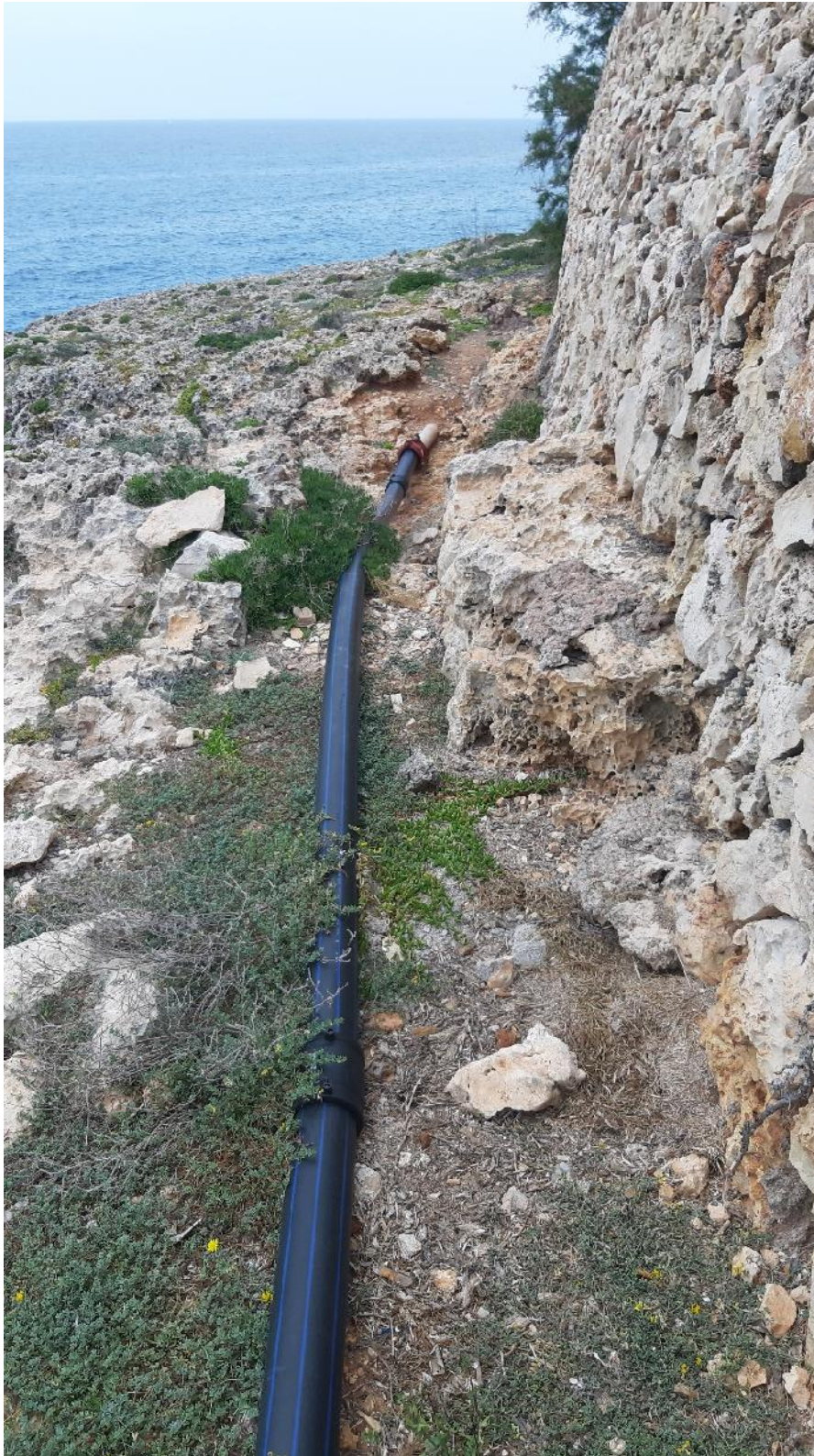
Foto Secuencia Foto: Tramo parcialmente soterrado conducto impulsión
