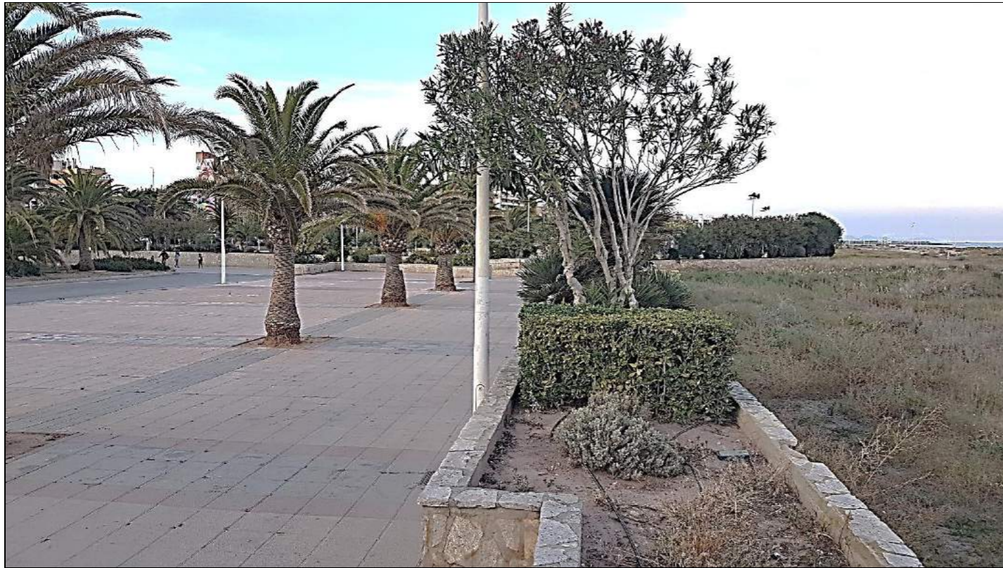
Fotografía de la jardinera-muro de separación entre el paseo marítimo y el fondo de la duna secundaria (hacia el Norte)
