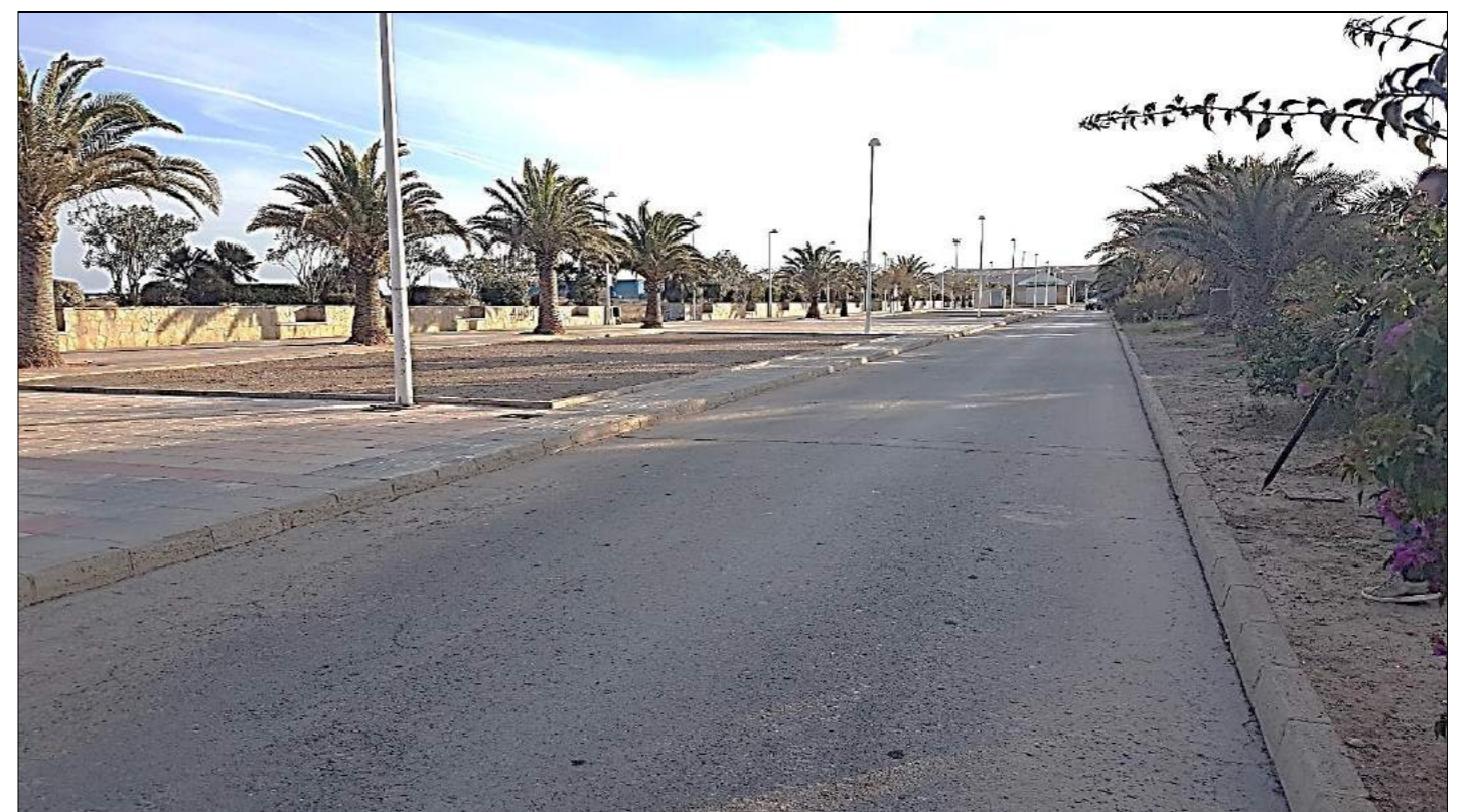
Foto del paseo marítimo con el nuevo vial longitudinal entre paseo y franja de terrenos ajardinados en talud (hacia el Sur-Puerto)
