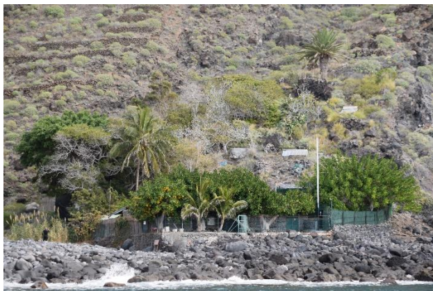
Foto 35. Edificación con vegetación
