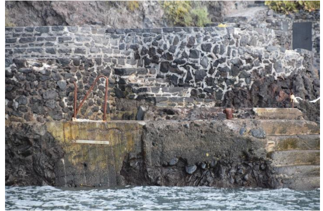
Foto 46. Embarcadero. Detalle. Margen norte
