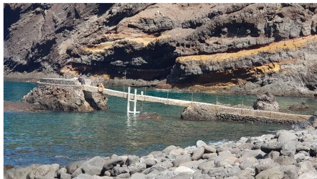
Foto 4. Pasarela tras obras de emergencia. Junio 2018
