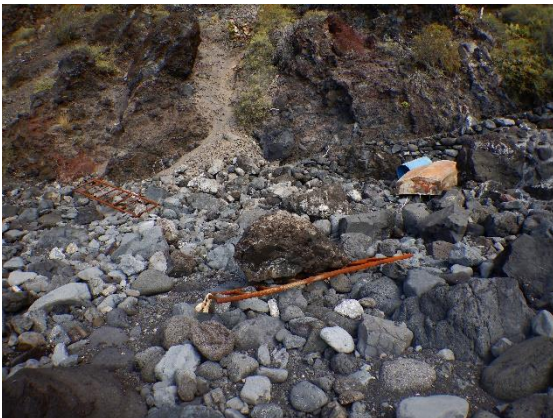
Foto 53. Restos de escalera del embarcadero
