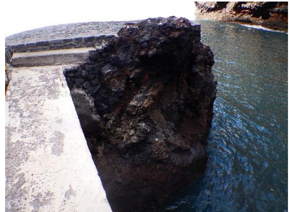
Foto 50. Detalle pasarela en punto de conexión con embarcadero
