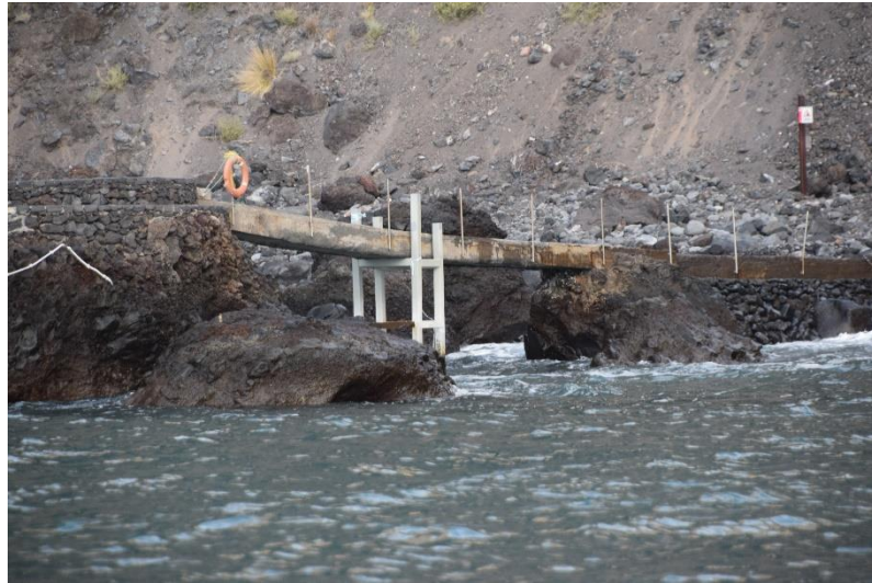
Foto 52. Pasarela y apoyo de acero
