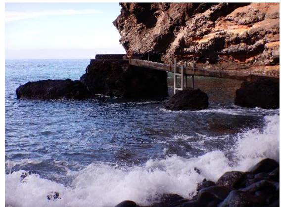
Foto 5. Pasarela tras obras de emergencia. Noviembre 2018
