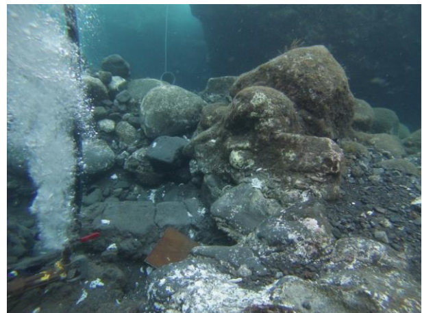
Foto 10. Zona con colada sana
