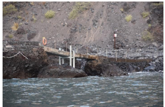
Foto 42. Embarcadero y pasarela. Margen sur
