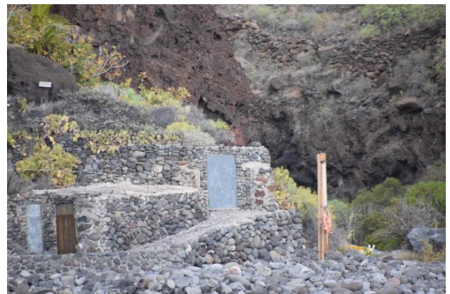
Foto 36. Edificación revestida en piedra natural
