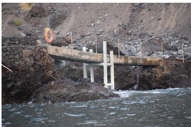
Foto 43. Pasarela. Detalle apoyo. Margen sur
