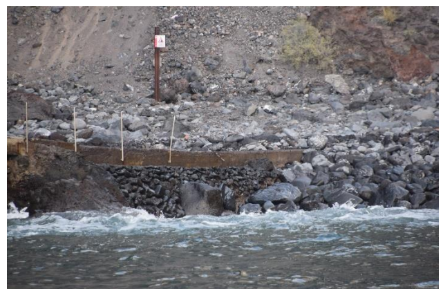
Foto 44. Pasarela. Inicio. Margen sur
