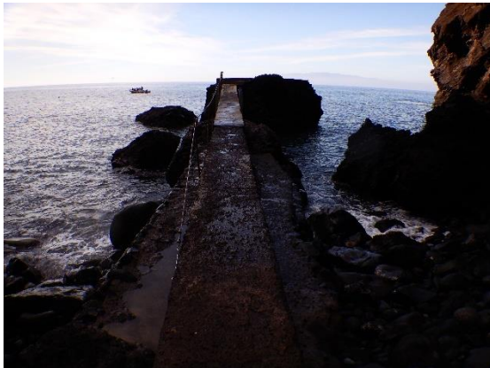
Foto 49. Vista de pasarela desde inicio en tierra
