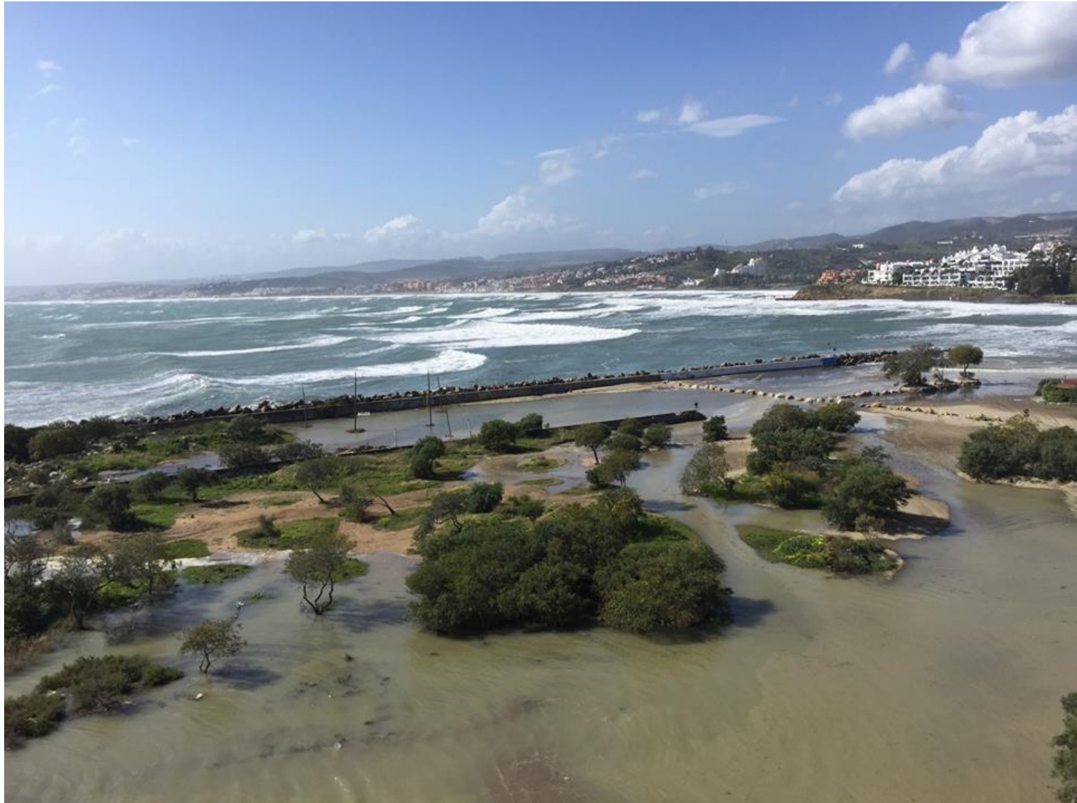
Foto nº 5. Tomada desde el mismo punto que las anteriores, con giro panorámico hacia poniente, y visualización de la inundación hasta el extremo de poniente, en la otra zona abierta (además de las zonas de desmoronamiento de los muros) de penetración directa del mar por la playa.
