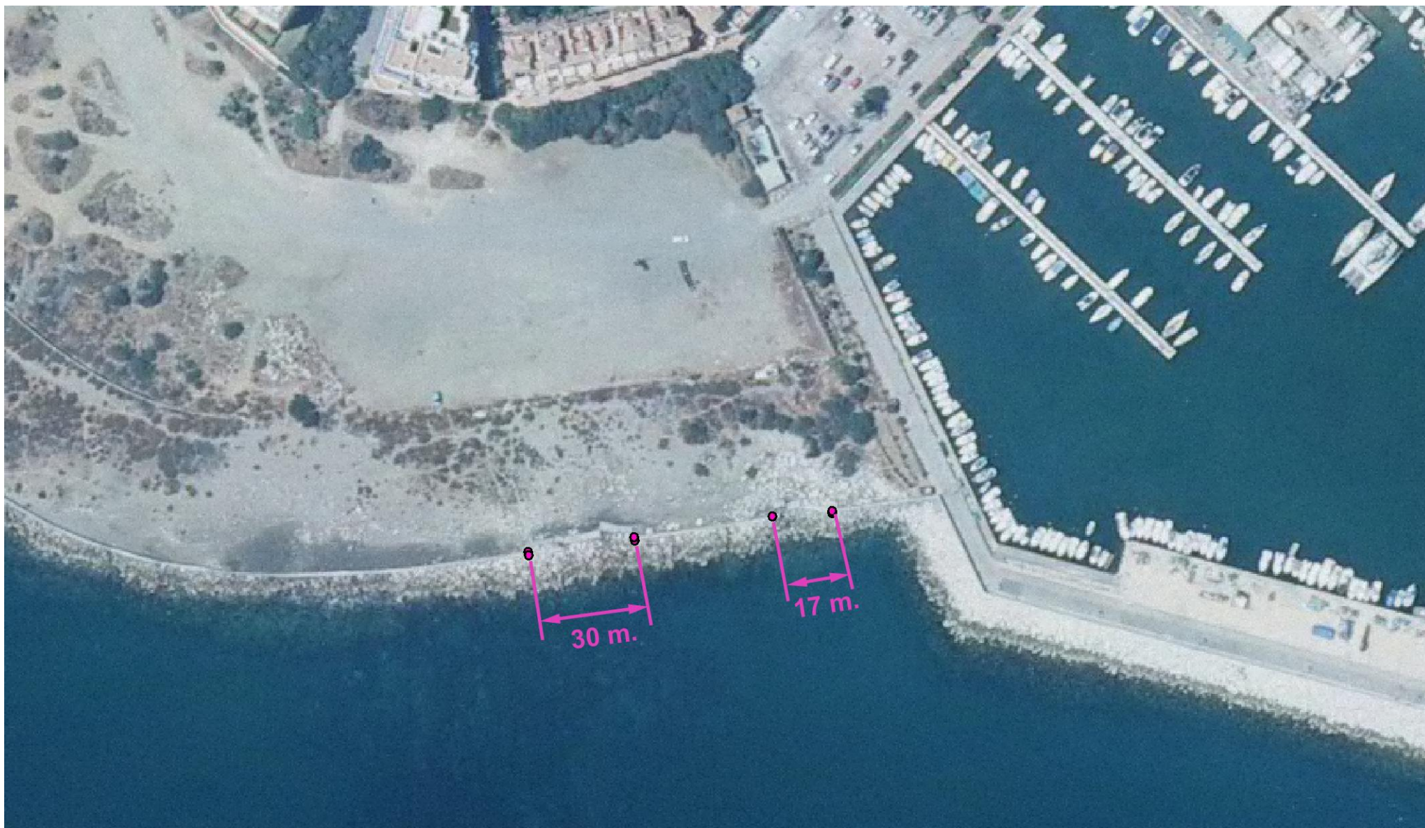
Tomas G.P.S. de los puntos extremos que delimitan las dos zonas derruidas de muro y escollera.
