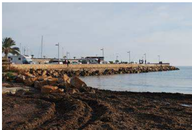
Fotografía 3: Zona norte de La Llana, fuertemente erosionada, al abrigo del espigón sur de la zona portuaria. Zona cubierta de arribazones de Posidonia oceanica . Año 2018
