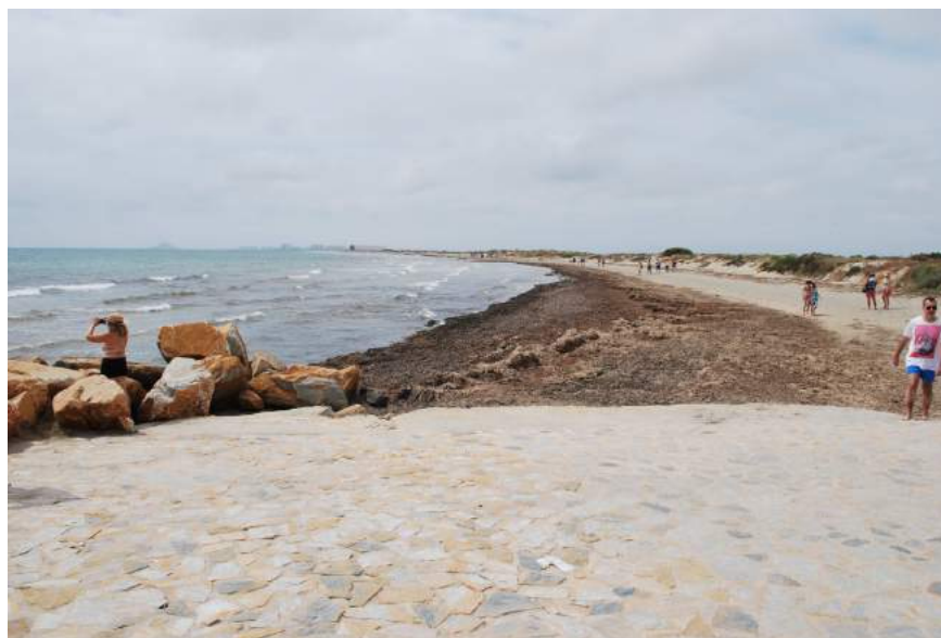
Imagen 11. Acceso norte desde aparcamiento del puerto de San Pedro del Pinatar a la playa de La Llana, donde la erosión ha dejado parcialmente descalzada e inutilizada la losa de acceso a la playa. Junio 2.019.
