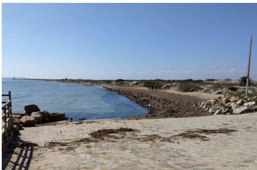
Imagen 12. Acceso norte desde aparcamiento del puerto de San Pedro del Pinatar a la playa de La Llana, donde la erosión tras el temporal de septiembre de 2.019 ha dejado totalmente descalzada e inutilizada la losa de acceso a la playa.
