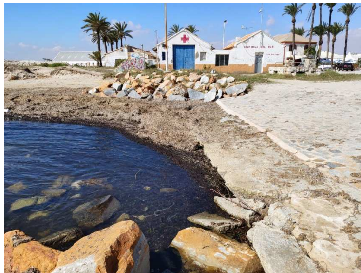
Fotografía 6: Losa de hormigón para acceso a playa de La Llana, descalza y sin conexión a playa seca tras DANA Septiembre 2019
