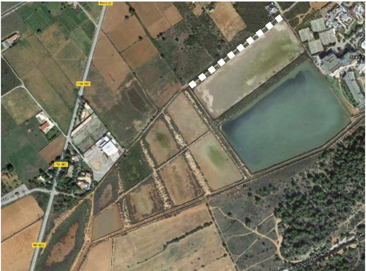
Fotograma 19. Tramo afectado por la medida correctora M-12 del EIA.
