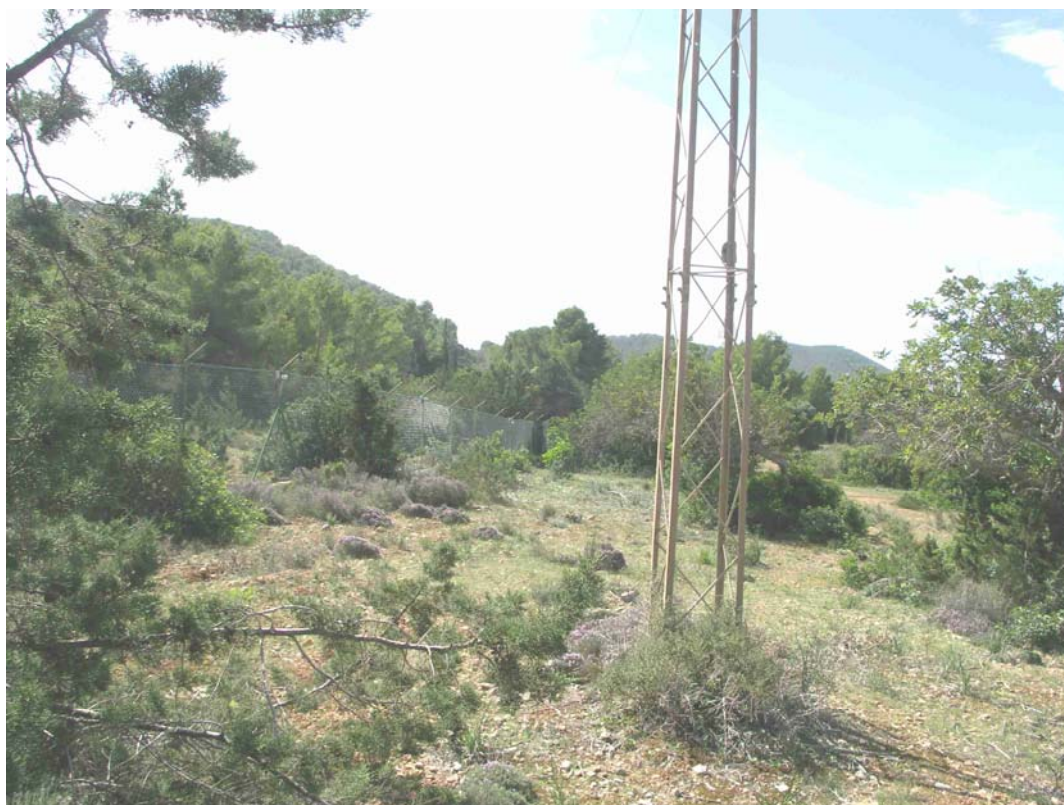
Foto 71. Detalle del a poyo que se sustituye por otro que permite la bajada –subida de líneas. La nueva línea de MT soterrada finalizará en este mismo punto.
