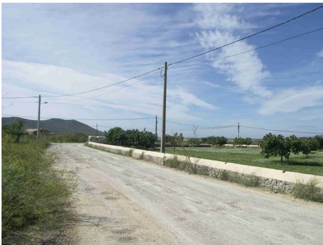
Foto 56. Final del camino en Sant Francesc . Tendidos telefónicos a eliminar.
