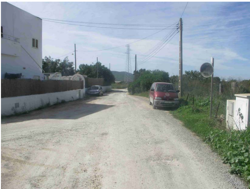
Foto 53. El mismo camino rodable afectado, a su paso por una zona urbana con varias viviendas., que se verán beneficiadas por la retirada de tendidos aéreos.
