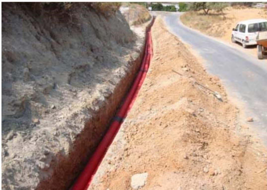
Foto 22. Ejemplo de acopio de tierras a pie de zanja.
