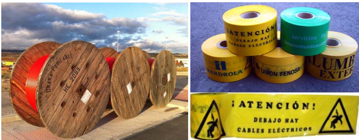
Fotos 29 y 30. Bobinas de cableado eléctrico, y cintas señalizadoras.
