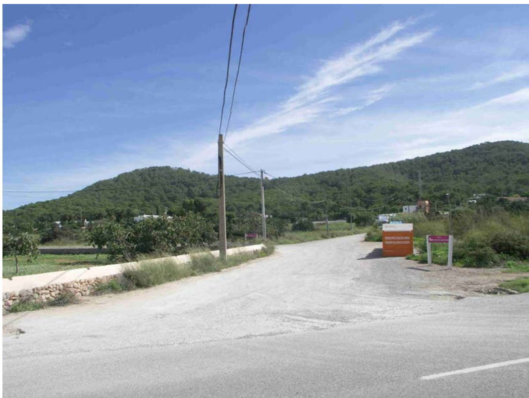
Foto 75. Tramo de línea de telefonía a eliminar, cruzando sobre la carretera PM-802.
