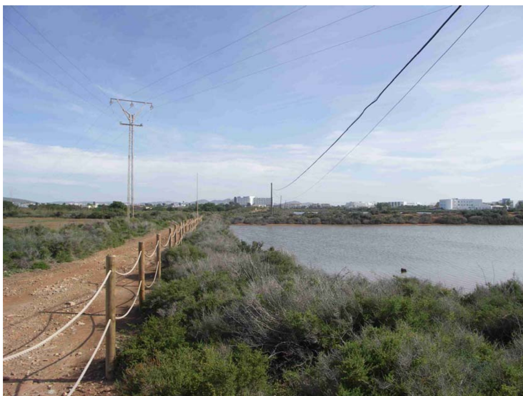
Foto 20. Siguiendo tramo del camino afectado. El tendido telefónico a eliminar transcurre dentro de la zona húmeda.
