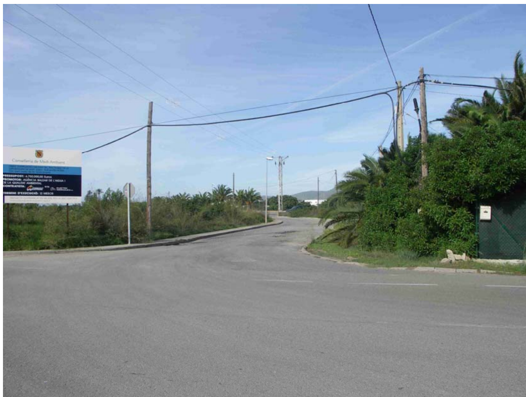
Foto 15. Cruce del camino anterior con la carretera PM-801 ramal 802 a La Canal. Todos los tendidos visibles de MT y telefonía se eliminan, y se instalan nuevos y soterrados.
