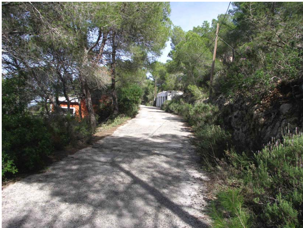
Foto 79. Continuación del camino pavimentado ascendente por el que transcurre la línea de BT proyectada.
