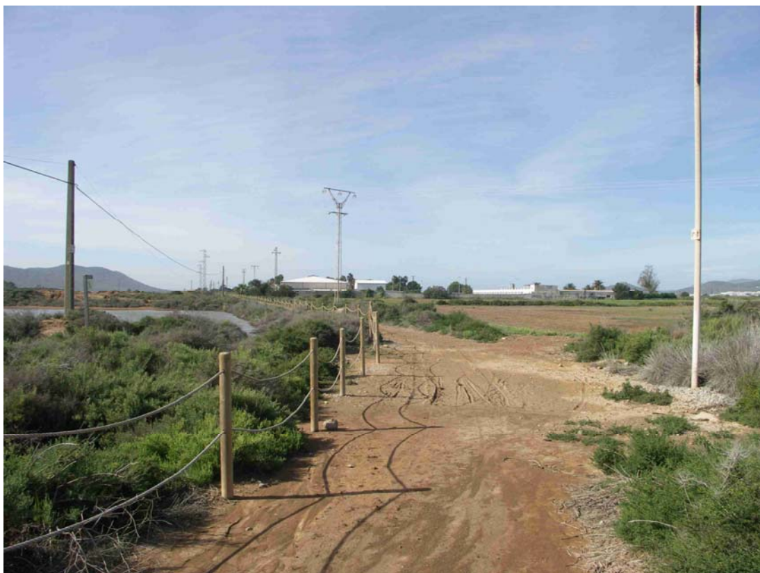
Foto 21. Enfocando hacia el sur, entrada a un campo de cultivo contiguo, propuesto como posible zona de acopio de materiales (la nº 3 del plano 42 del EIA).
