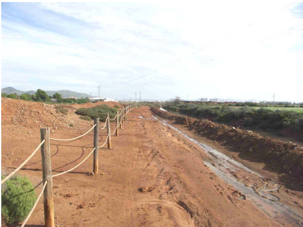
Foto 6. Más hacia el norte, tramo encharcado por la proximidad del nivel freático y la naturaleza arcillosa de los suelos. A la derecha, se aprecian acopios de materiales del reciente dragado del canal de pluviales de la salinera. Vallado de protección de zonas húmedas.
