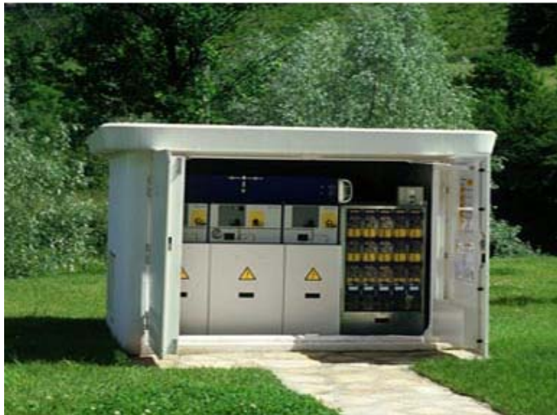
Foto 31. Ejemplo de CD compacto tipo miniblock de Ormazábal.
