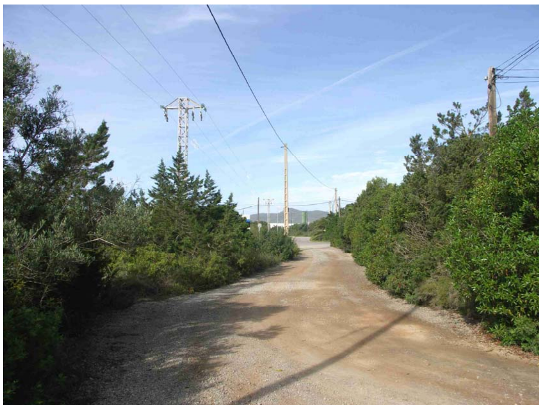
Foto 14. Siguinte tramo del mismo camino, que da acceso a las viviendas de la zona de "Isla Blanca". Eliminación de tendidos MT y telefonía, e instalación de nuevas líneas.
