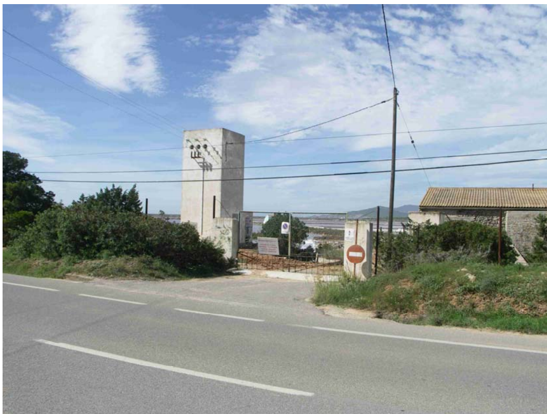
Foto 72. Junto a la carretera PM-802, tendidos eléctricos y telefónicos que se eliminan, y nuevas líneas soterradas de MT y telefonía que cruzarán la PM-802 en este punto.
