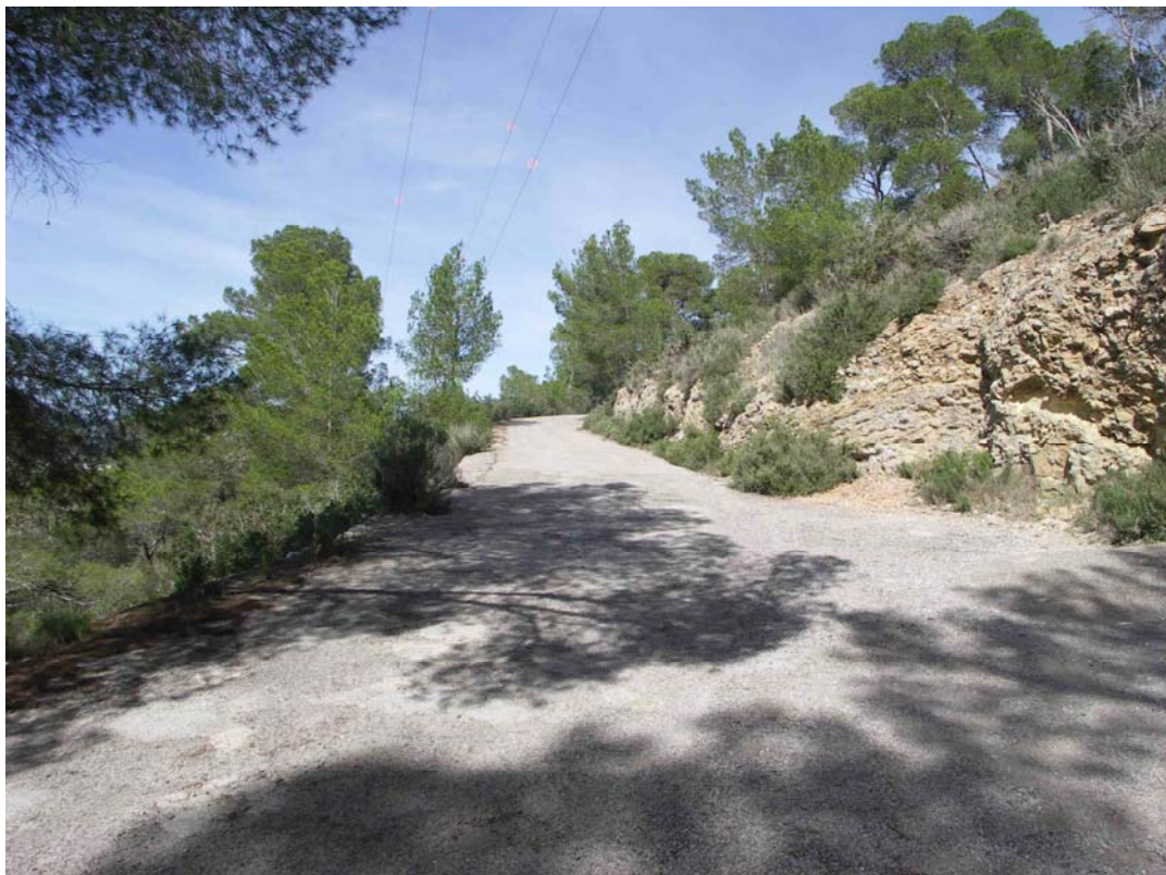
Foto 81. Otro tramo ascendente del camino o calle pavimentada afectada por la línea de BT.
