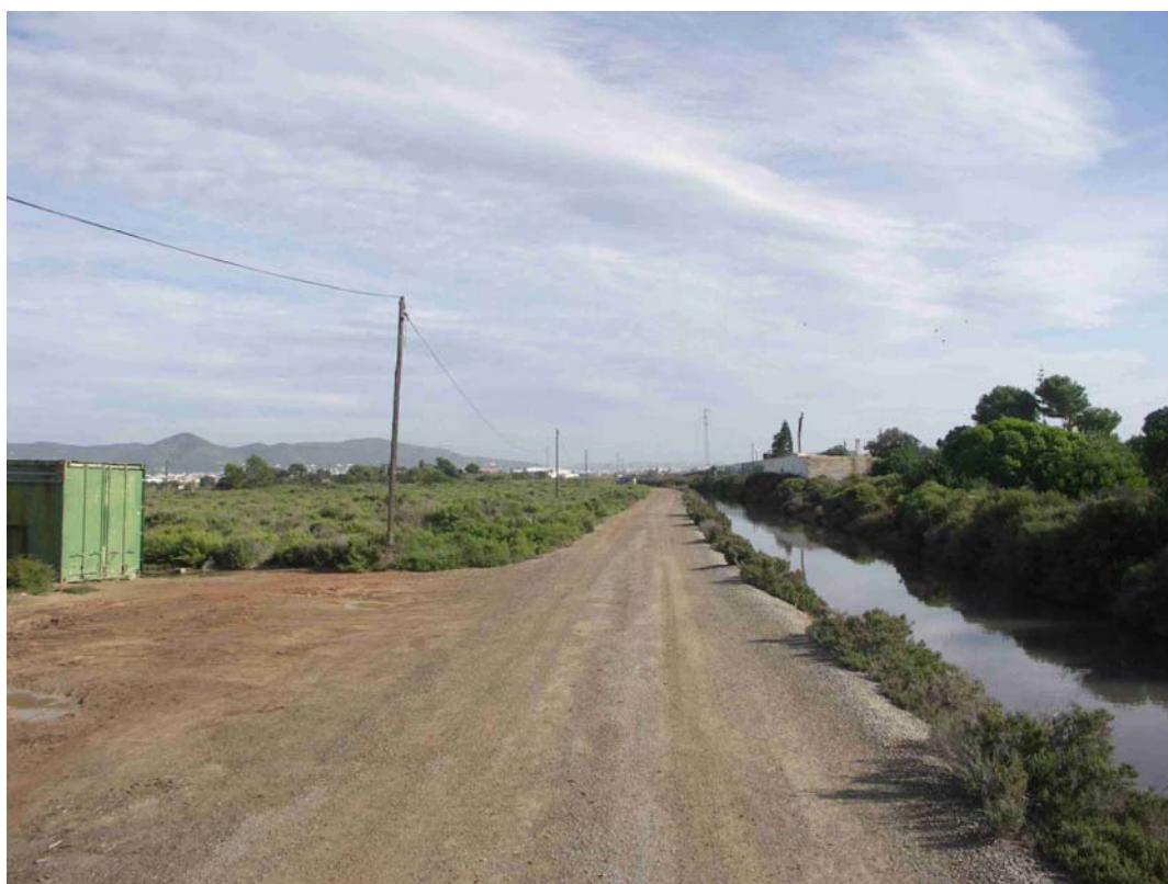
Foto 4. Continuación del camino hacia el norte. Vegetación de saladares junto al camino, a ambos lados. Canal de pluviales de la salinera. Por este tramo va una línea de MT y una de telefonía. El tendido telefónico que se aprecia, se elimina.
