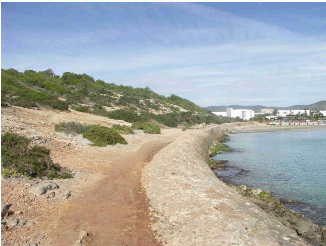
Foto 37. Ladera por la que asciende la ruta propuesta, para acceder a la zona de la torre de Sal Rossa .
