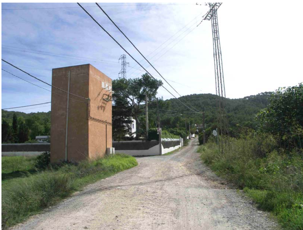
Foto 59. A la derecha, torre de apoyo del tendido aéreo de MT que se elimina. También se suprime el tendido telefónico visible.
