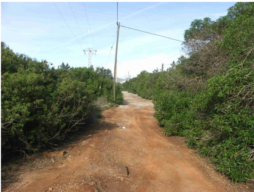
Foto 13. Camino vecinal que conecta con el anterior, y que da acceso desde la carretera a varias viviendas. En este camino se eliminan tendidos eléctricos y telefónicos, y se instalan nuevos tendidos de ambos tipos.
