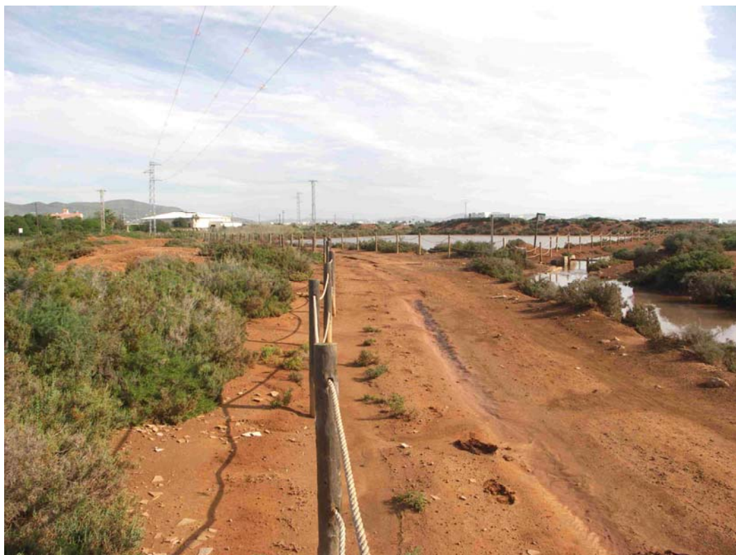
Foto 9. El camino, en este tramo, es de limo arcilloso fino, muy encharcable y resbaladizo.
