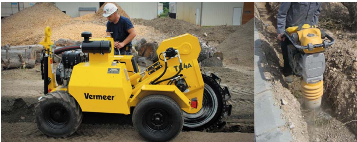
Fotos 16 y 17. Compactadora, manual (derecha) y compactadora motorizada, para compactado de zanjas y de la solera del nuevo transformador.
