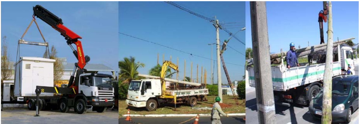
Fotos 11 a 13. Camión grúa, para retirada de postes y torres e apoyo (centro y derecha), carga y descarga de bobinas, y para colocación de transformador monoblock Ormazábal (izquierda).
