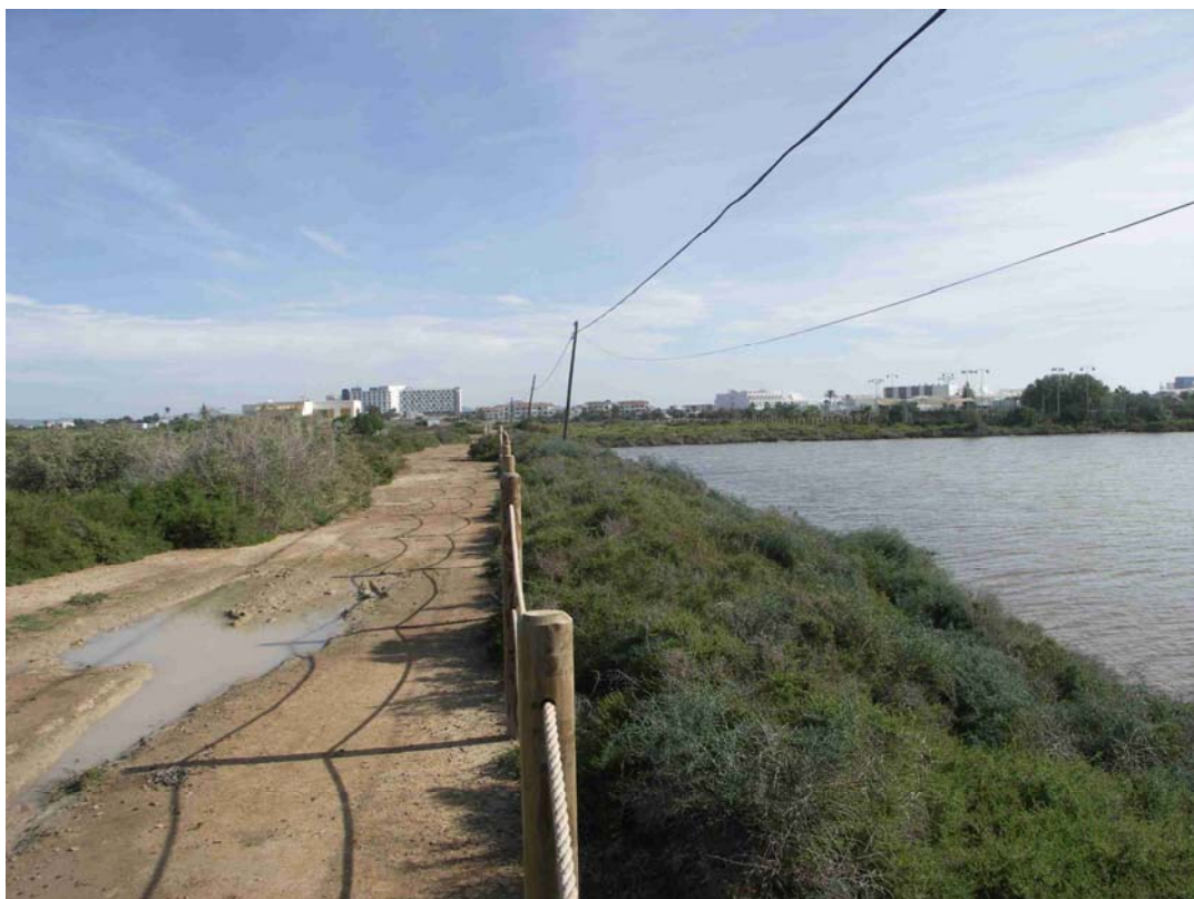
Foto 23. Continuación del mismo tramo. Se ha propuesto, como medida correctora, una empalizada de aislamiento visual entre el camino y el estanque contiguo, para reducir impacto sobre las aves acuáticas.
