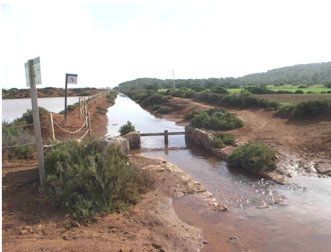
Foto 10. Camino que se suprime mediante vallado. Este acceso es impactante por transitar junto a la zona húmeda.
