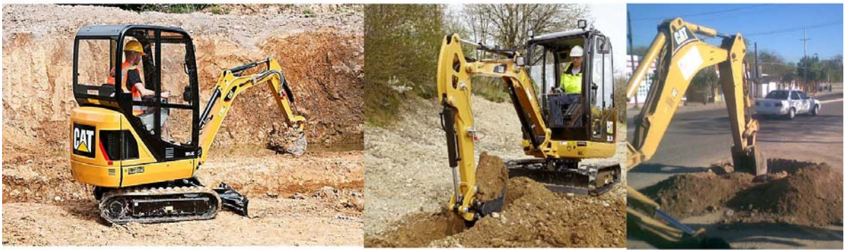
Fotos 3 a 5. Retroexcavadora o “mini-retro” para apertura y tapado de zanjas.
