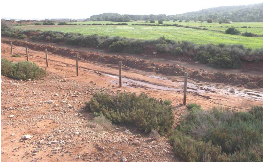
Foto 7. Perspectiva del mismo tramo de la foto anterior. Bajo este camino se instalarán una línea de MT y una de telefonía, ambas soterradas, y sobre él transcurre la ruta peatonal y ciclista propuesta.
