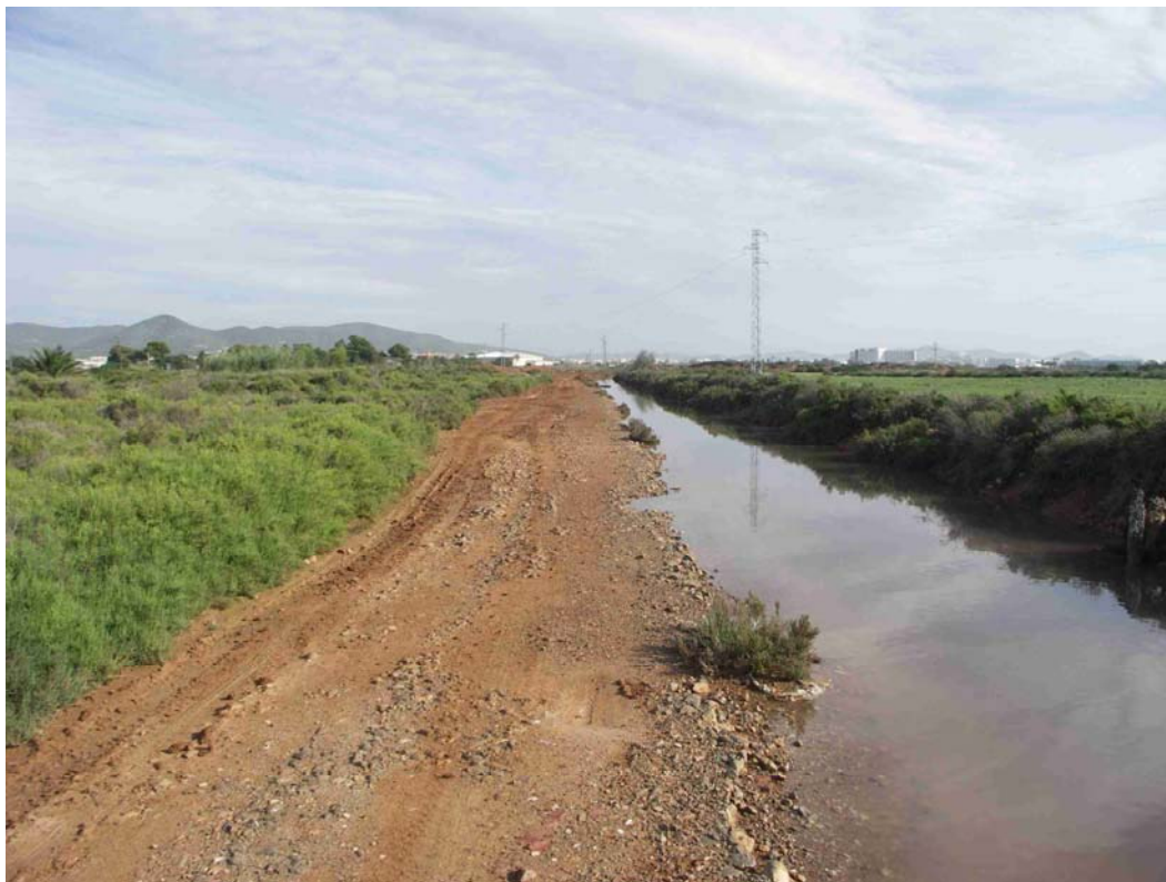
Foto 5. Continuación del camino, hacia el norte. Se estrecha y se acerca al nivel del cañal de pluviales. Este tramo suele estar encharcado en las lluvias más intensas. Vegetación de saladares ( Sarcocornia fruticosa , Suaeda vera , Arthrocnemum macrostachyum ).
