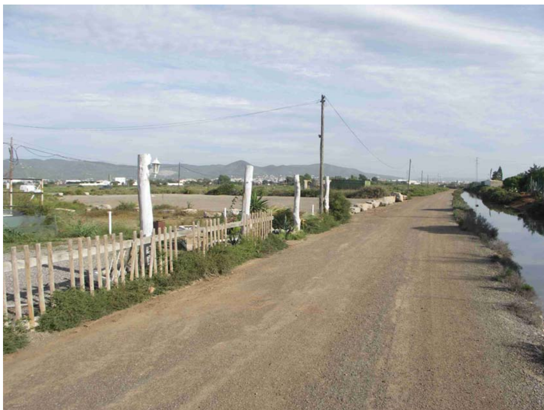
Foto 2. Continuación del camino en dirección norte. A la izquierda, explanada que se propone como una de las zonas de acopio de materiales. Tendido telefónico a eliminar.
