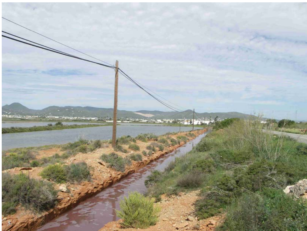
Foto 73. Tendidos telefónicos en el interior de la zona húmeda de ses salines des Codolar , que serán desmantelados. Se proponen medidas preventivas para no afectar a la avifauna y a la vegetación.
