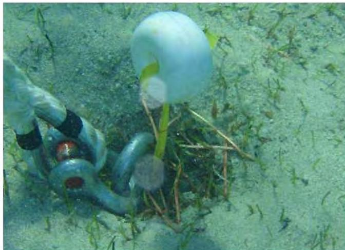
Foto 8. Detalle parte vista anclaje Manta Ray, señalizado
