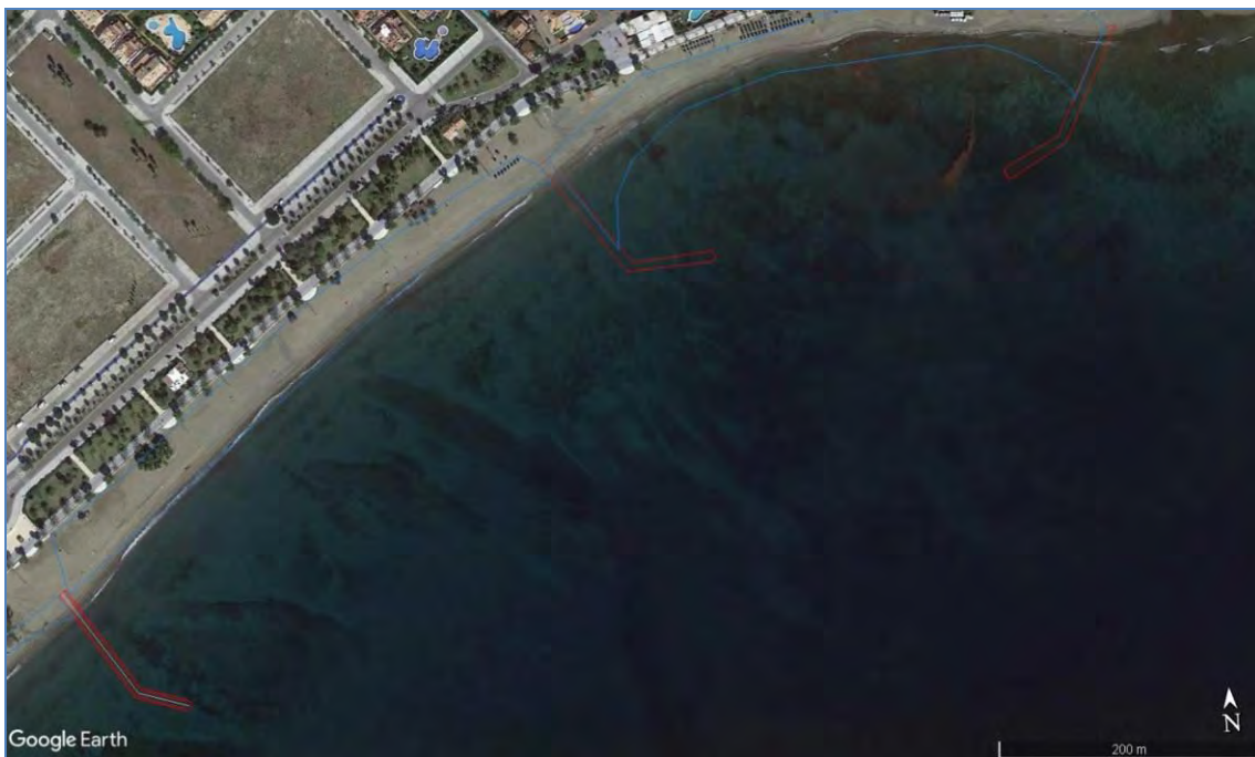
Ilustración 147. Manchas rocosas (2012). Espigones 1, 2 y 6
