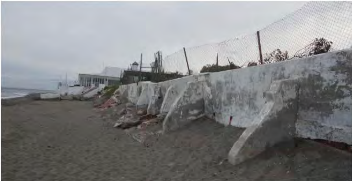
Ilustración 113. Muro divisorio de parcela privada en primera línea de playa (Fuente: Documento Ambiental, 2014)
