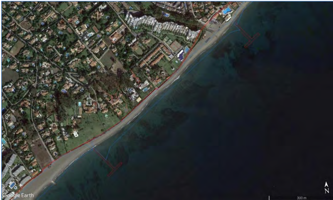
Ilustración 148. Manchas rocosas (2012). Espigones 3 y 4
