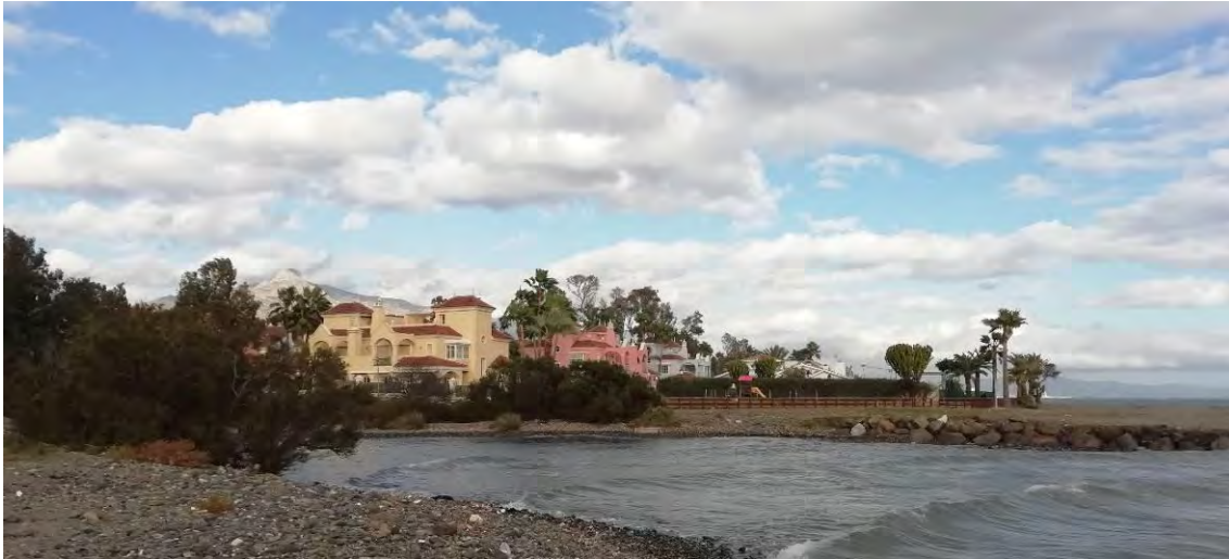
Ilustración 116. Vista de la UVI 1 (Fuente: visita de campo de noviembre de 2019)
