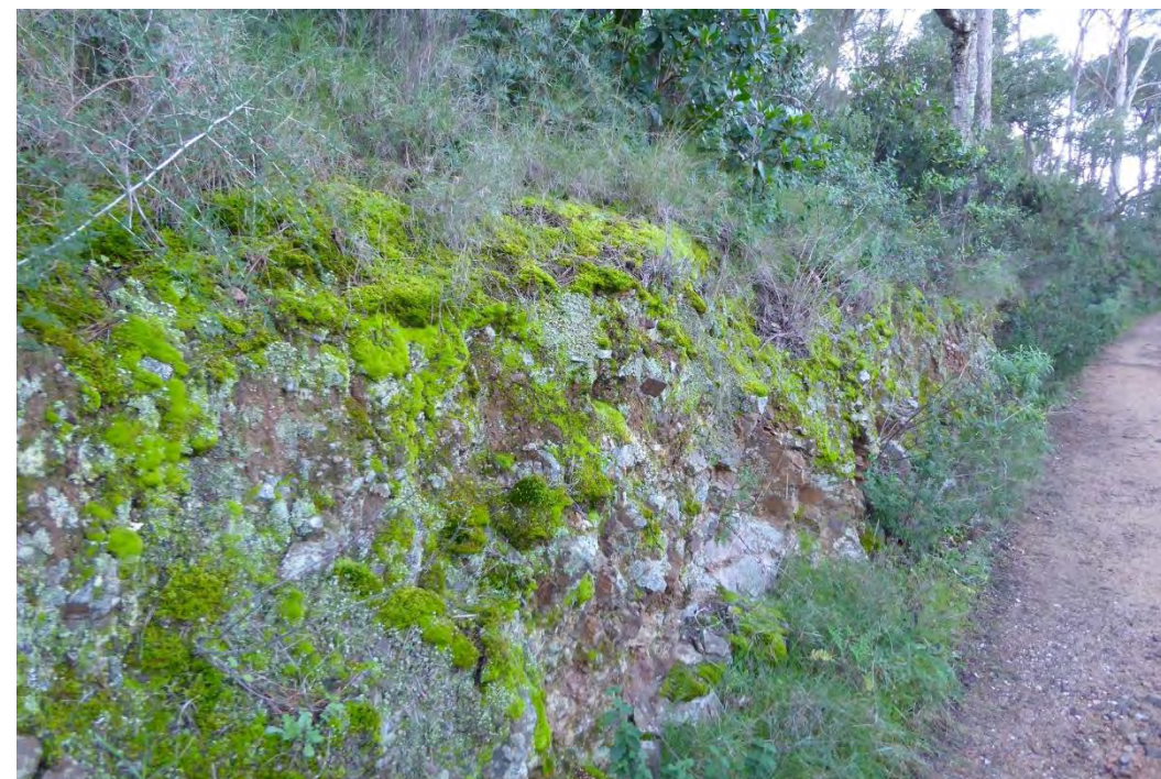
Imagen 4. El denso recubrimiento arbustivo-herbáceo y la humedad de las capas superficiales del suelo, favorecen la aparición de musgos y líquenes ( Cladonia sp.). Foto: © Alfred Encuentra.
