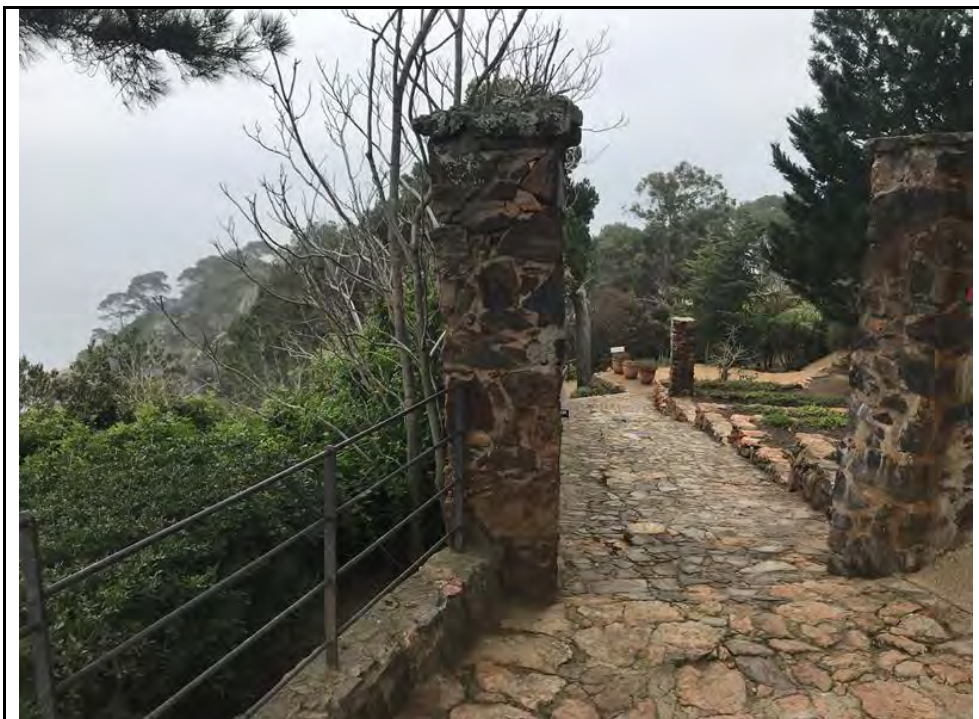
Foto 19: A.P. 2, Zona por donde pasará el camino. Zona donde se afectan bancales del jardín.
