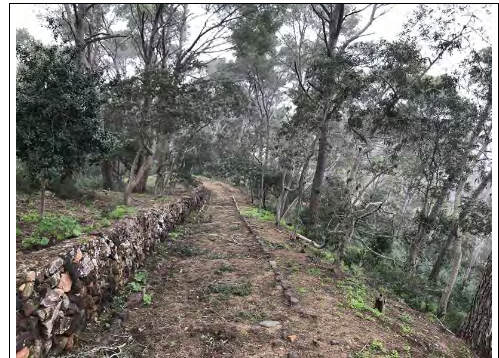
Foto 21: A.P. 2, Camino actualmente sin restaurar por donde pasará el nuevo camino de ronda.
