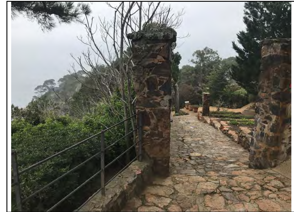
Foto 24: A.P. 2, Zona por donde pasará el camino. Zona donde se afectan bancales del jardín ED 5.
