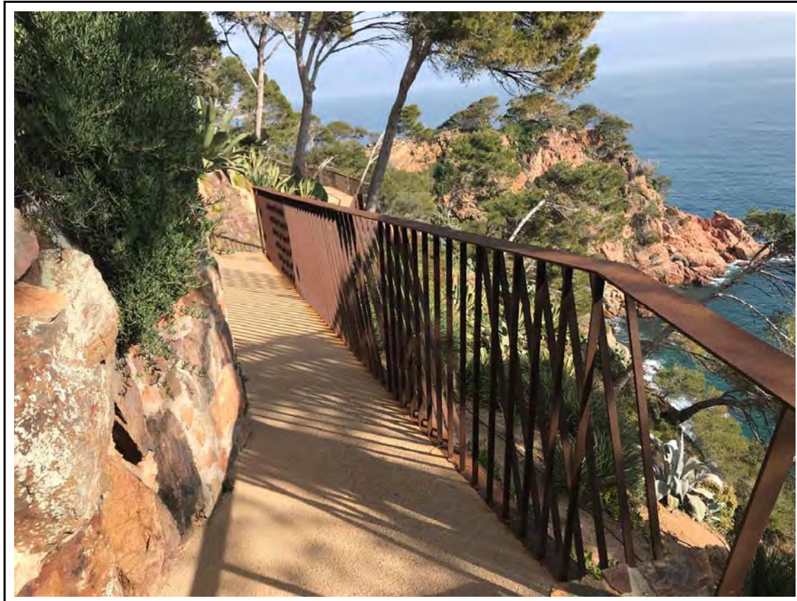
Foto 15: A.P. 2. Inicio de la zona de prospección. En primer plano, el camino actual.
